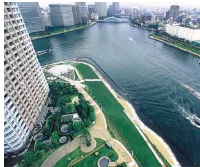
緩傾斜の堤防（石川島公園） 写真：大川端パンフレット
