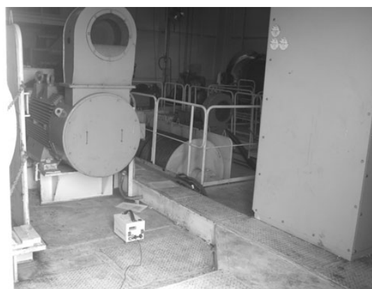
写真-3.1 微動計の設置状況
