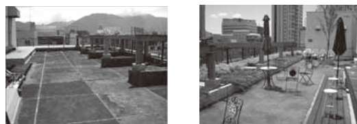
図-4 屋上緑化対策前後の状況
