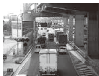
写真-1 騒音対策で苦慮している現場の事例
