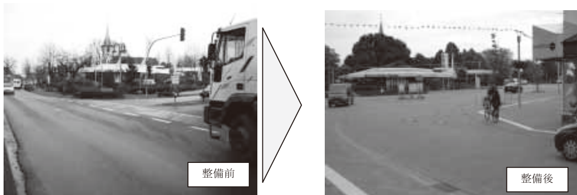
写真ー1 シェアド・スペースの整備例(ドイツ・ボーテム)
