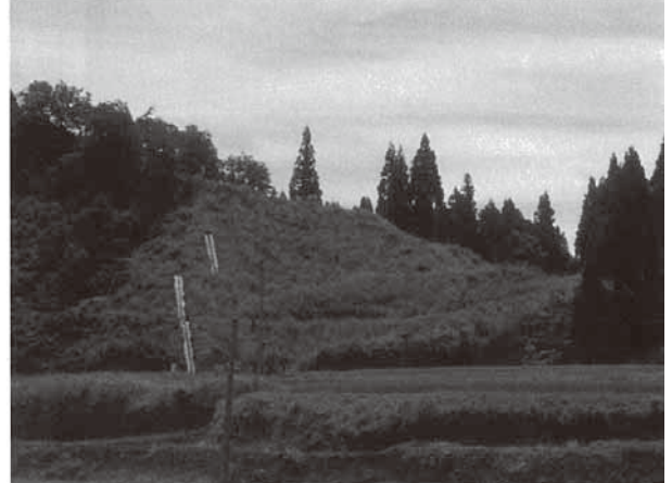
写真4. 表土を利用した事例；新潟県南魚沼市 （施工1年10ヵ月後）
