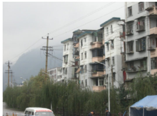
写真 4.2.3.23 立入禁止区域内の被災住宅全景
