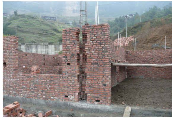
写真 4.3.2 山間部（映秀）における住宅再建の様子
