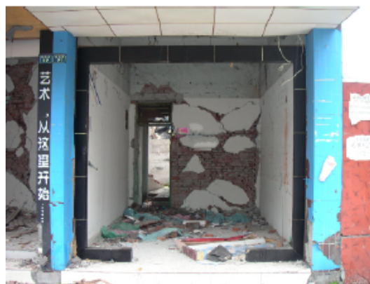
写真 4.2.3.2 （店舗兼住宅 1）1 階内部の破壊状況
