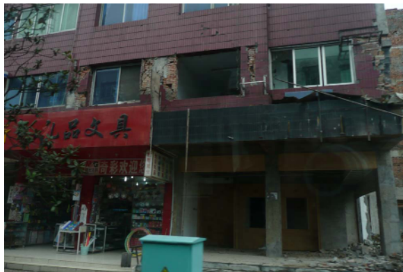
写真 4.3.4 市街地（都江堰）における店舗併用住宅（1階はRC造2階以上は枠組み組積造）の被害
