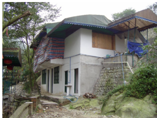
写真 4.2.7.10 2階建てで被害が軽微な住宅 (No.1)
