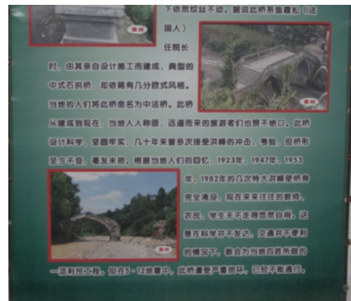
写真 4.2.4.10 敷地内に掲示された地震発生前後の比較写真2(「中法橋」と呼ばれる歴史的建造物で、写真 4.2.4.7 と同じ橋。上段右が震前、下段が震後)
