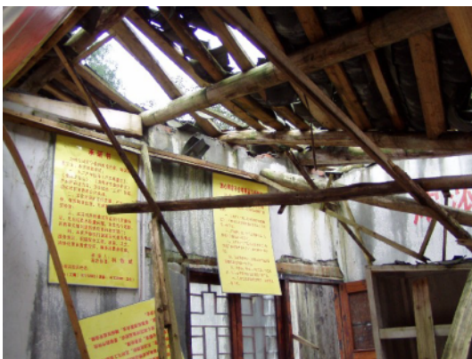
写真 4.2.7.9 組積造の典型的な倒壊パターンの一つであるゲートル崩壊による屋根の落下 (No.7)
