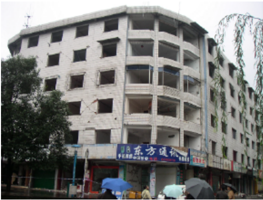
写真 4.2.3.5 (店舗兼住宅 3) 1階柱の曲げ破壊 + 2階以上の部分的組積壁のせん断破壊
