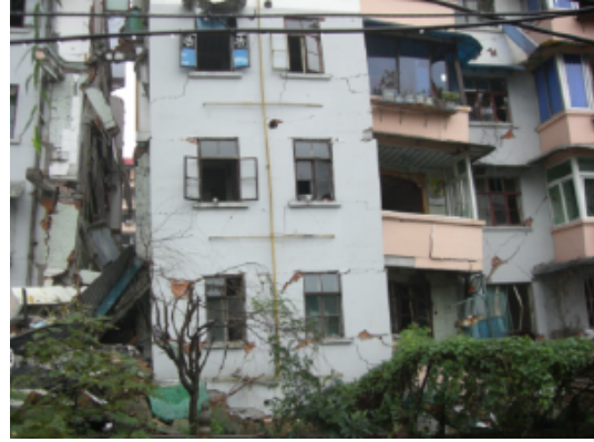
写真 4.2.3.25 立入禁止区域内住宅の被害状況
