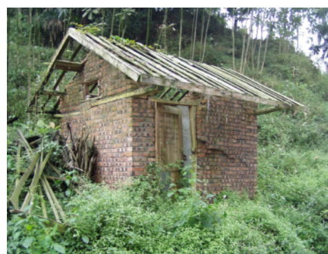
写真 4.2.7.2 レンガ造小規模建物 (No.6) 壁の大きなせん断クラック、瓦の落下などが見られるが、原型を留めている。
