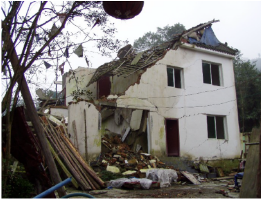
写真 4.2.7.7 地区でもっとも大きな住宅 (No.10) 無補強レンガ造。PCa パネルを受ける梁のみ RC 部材で、柱はない
