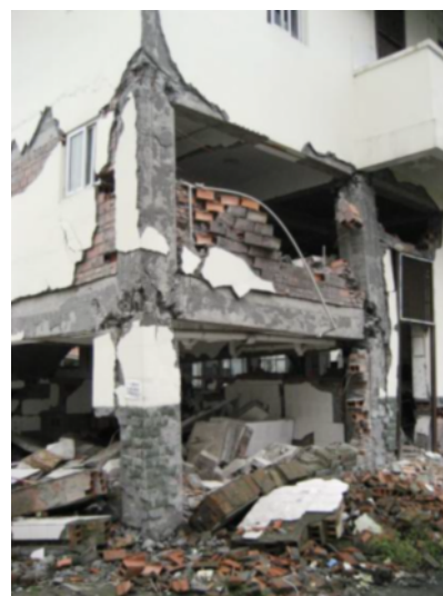
写真 5.12 柱頭・柱脚の曲げ破壊（映秀）
