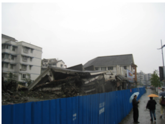
写真4.2.2.5 倒壊した共同住宅
