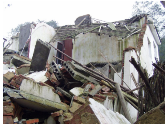
写真 4.2.7.8 同左。床に PCa パネルを使用していたことが分かる
