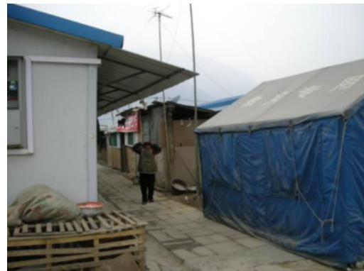
写真 6.3.3.2 仮設住宅の増築
