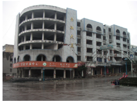
写真 4.2.3.6 (金融ビル) 1階柱曲げ破壊および2階以上組積壁のせん断破壊
