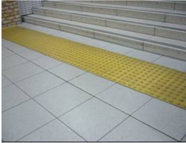
写真-付 4. 1. JR 三ノ宮における設置状況（左側が壁、上側が阪急方向）
