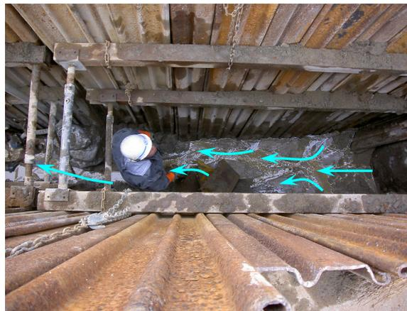
←P-8 仕切り板設置時 作業員退避状況。地下水の流出が続く。
