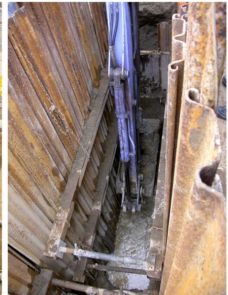
↑P-4 仕切り板設置後の掘削状況。掘削部は水没している。水面高さがGL-2.0~2.5m程度。
