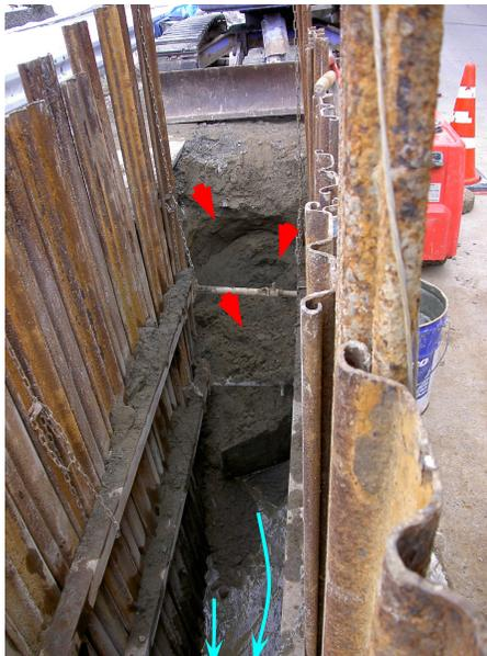
↑P-1 写真奥の重機側に工事は進行。掘削部の崩壊が確認される。地下水はGL-1.5m付近から常時流出している。
