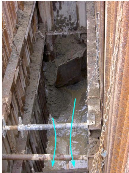
↑P-6 掘削部近景。地下水の流出が進行する。泥濘化した砂質土もあわせて流出する。
