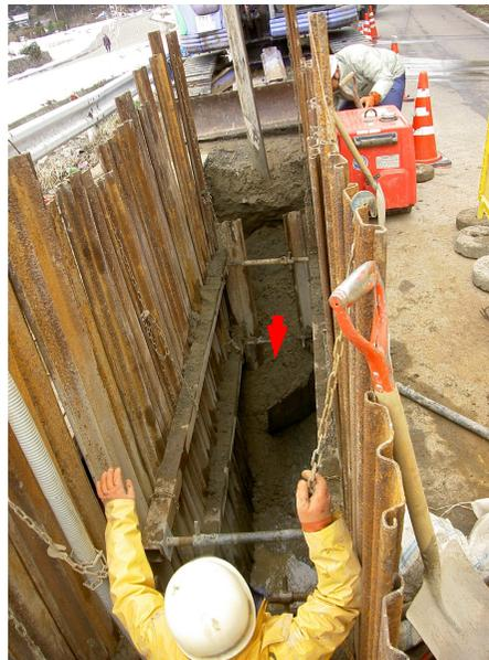
↑P-2 崩壊防止のための仕切り板設置準備状況。
