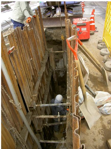
←P-7 掘削中に仕切り板周辺部に異音(軋音)が連続して確認されたため、掘削を中止し再設置。異音は写真奥の重機側の掘削部の崩壊により土圧がかかるためと想定される。
