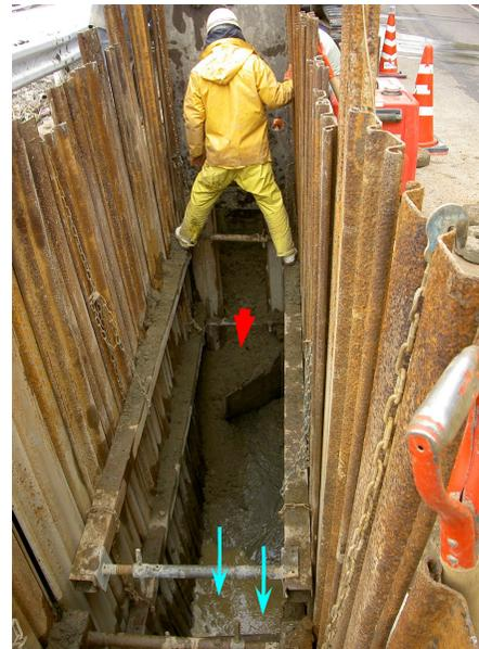
↑P-3 崩壊防止のための仕切り板設置状況。
