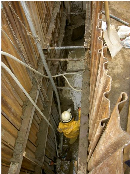
↑P-5 掘削状況。掘削面は水没している。
