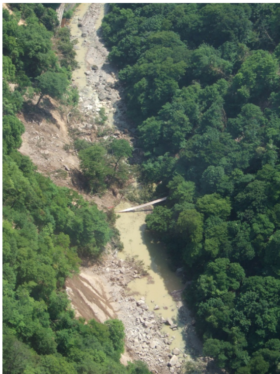
写真一 1 1 温湯（平成 20 年 6 月 20 日国総研撮影）
