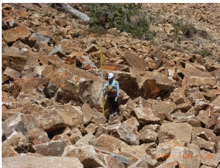
写真一 6 湯ノ倉（平成 20 年 6 月 20 日国総研撮影）
