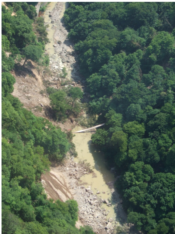
写真一 1 1 温湯（平成 20 年 6 月 20 日国総研撮影）
