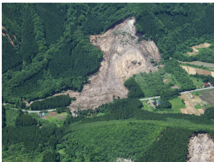
写真－12 小川原 (平成 20 年 6 月 15 日国総研撮影)
