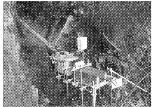
斜面末端観測施設の設置状況
