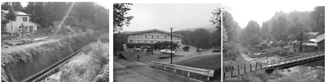
写真－1 左) 桧木内川下流の保全家 中央) 蟹沢下流の国民宿舎 右) 先達川右岸の孫六温泉
