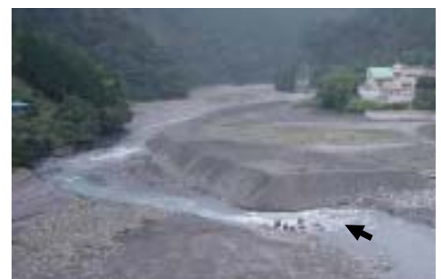
写真-2 38.9km 地点置土 （延長 280m、体積 10,000m 3 ）
