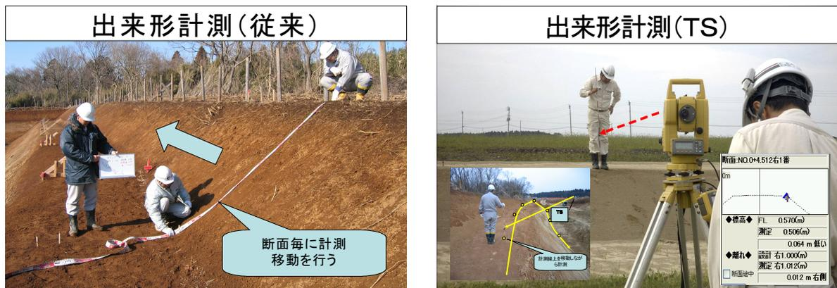
図 2-4 出来形管理システムによる現場計測手法の違い
