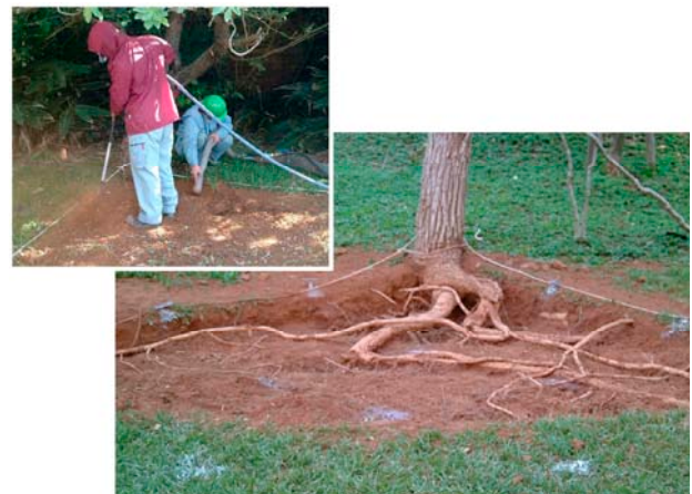
写真1 圧縮空気を利用した土壌掘削
