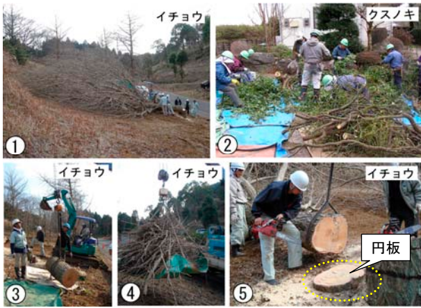
写真1 地上部の伐倒作業
