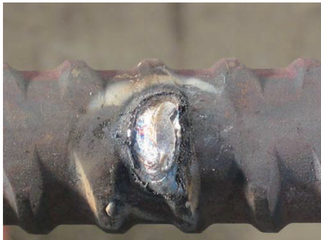
写真-2.4 鉄筋取り外し後の状態の例
