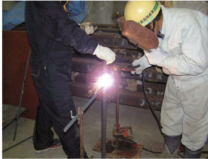
写真-2.2 PC鋼棒と鉄筋の溶接状況の例
