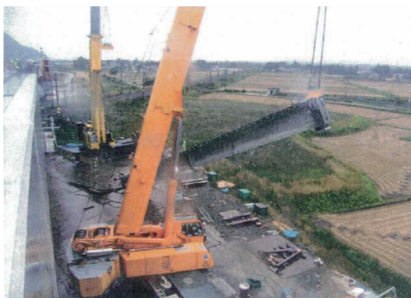
写真-1.1 架設用 PC 鋼棒の破断による桁落下
