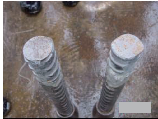
(b) PC 鋼棒破断部
