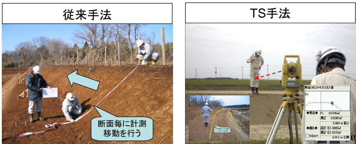
図 2-1 従来手法と TS 手法の出来形計測手法イメージ
