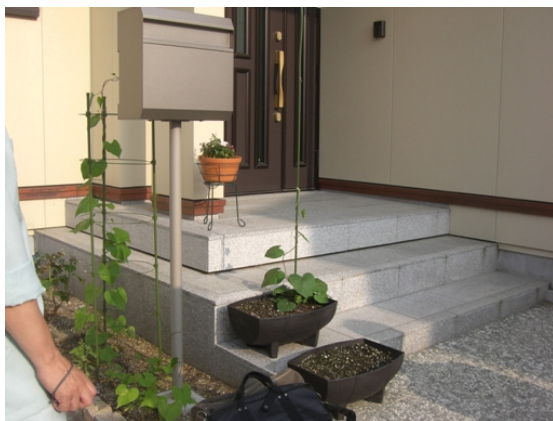
(a) 玄関付近（変状なし）
