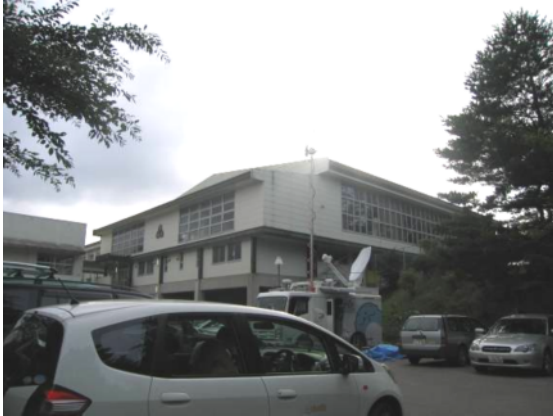
図-4.6 B建築物外観（東側より）
