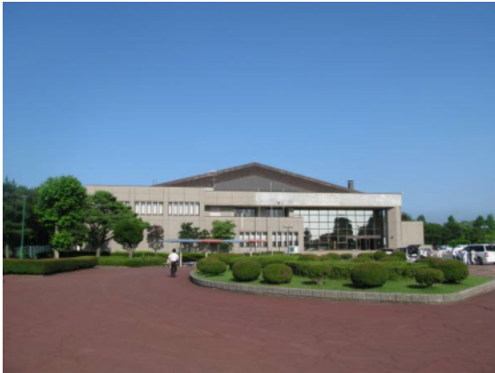
図-4.23 D建築物外観（右側に入口）
