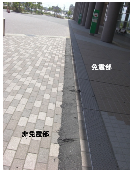
(b) 舗装の損傷（補修済み）
