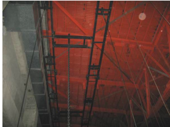
図-4.37 同上部の屋根面
