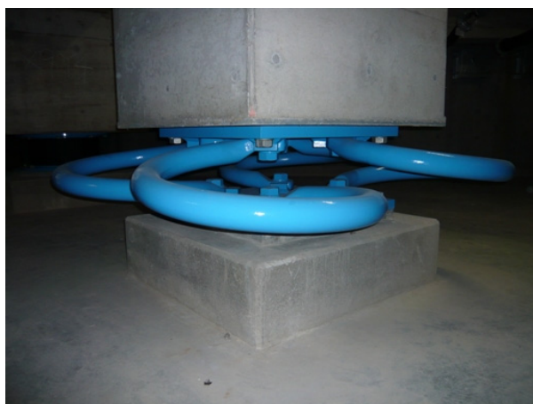
図-5. 4. 32 鋼棒ダンパー
