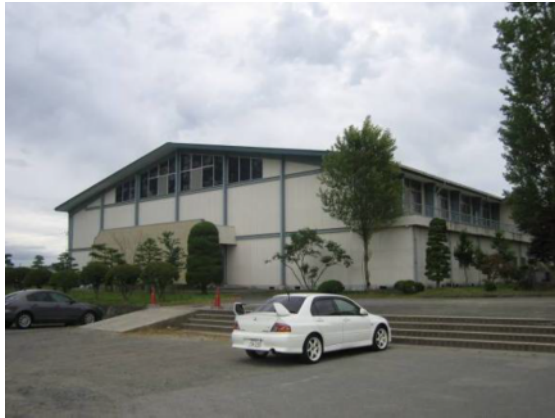
図-4.6 B建築物外観（北西方向より）
