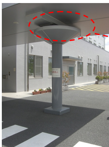
(d) 入口ポーチ支柱
