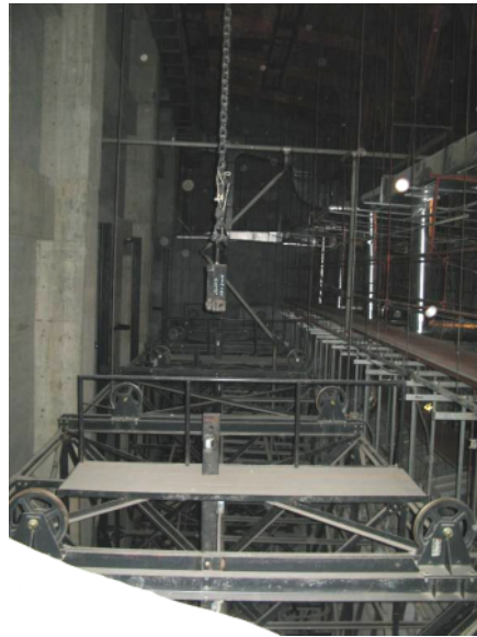
図-4.35 同上部の吊り状況
