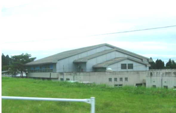
図-4.16 D建築物外観
