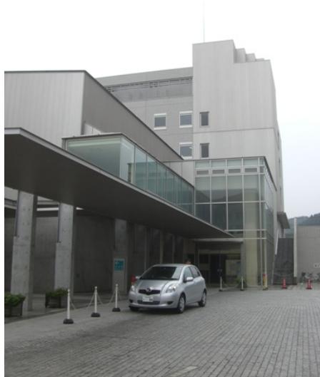
図-5.4.25 D建築物（RC造6階建て）
