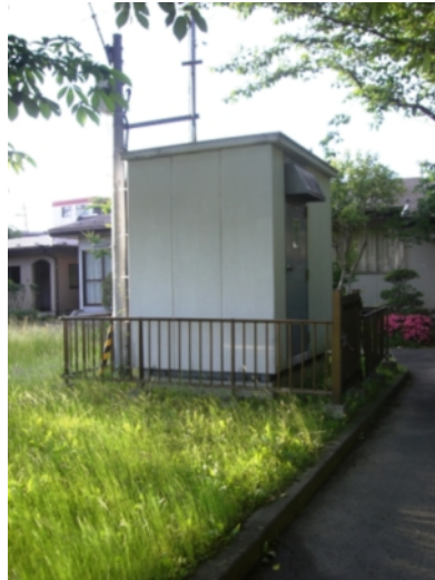
図-2.3.23 強震計設置状況（三日町公園）
