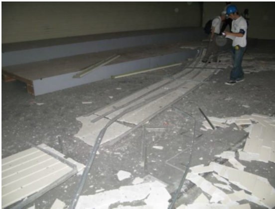
図-4.42 一体で脱落した天井板とダブル野縁
