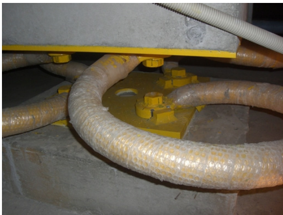
(c) 鋼材ダンパー及び塗料のはがれ
