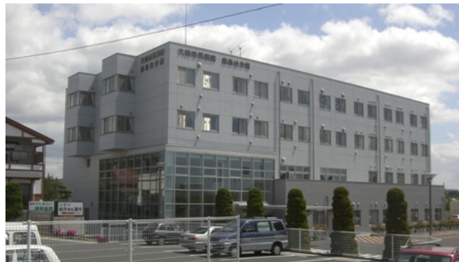
図-5.4.1 A建築物（RC造4階建て）
