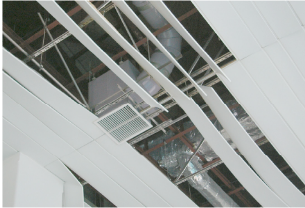
図-4.32 天井裏の状況
