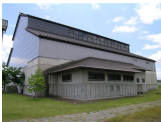
図-2.3.8 D建築物北面（高窓に被害なし）
