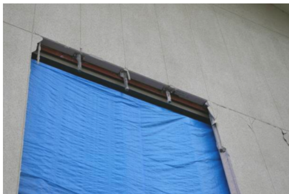
図-4.12 ALCパネルの上部取付け部
