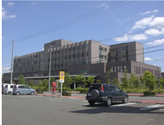
図-5.4.4 B建築物（RC造5階建て）
