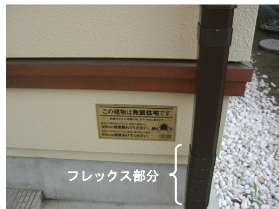
(b) 免震表示及び雨どいのフレックス部分
