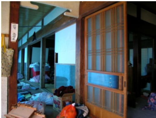
(c) 同住宅内部（特に躯体損傷なし）
