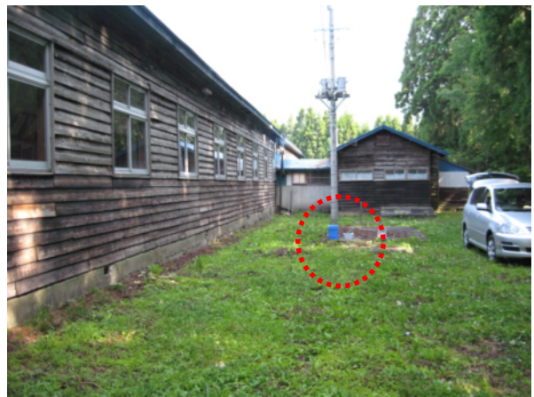
写真-3.8 鬼首中学校強震計設置状況
