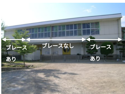
(a) 体育館外観及びブレース配置
