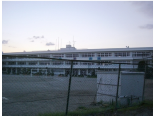
図-2.3.26 I 中学校新校舎外観
