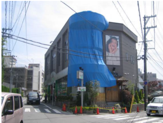
図-4.49 ガラスブロックが脱落した箇所
