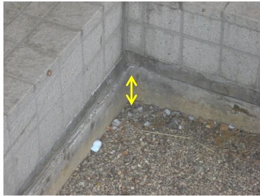
(b) 立上り部の露出（最大5 cm程度）
