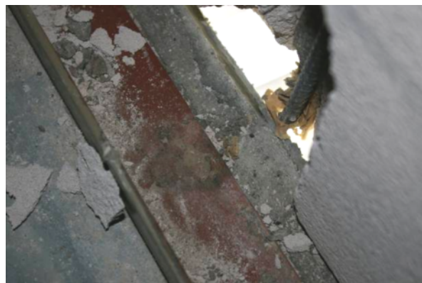
図-4.13 溶接跡の見られるALCパネル下端部
