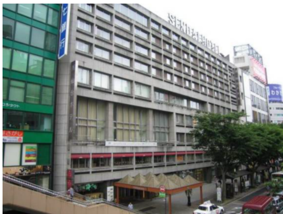
図-4.2 A建築物外観
