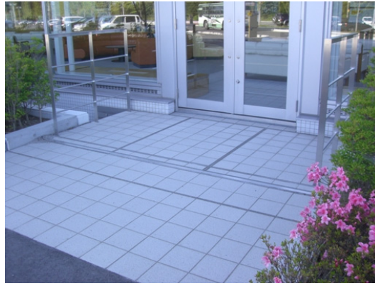
図-5.4.22 I 棟南東側出入口エキスパンション（無被害）
