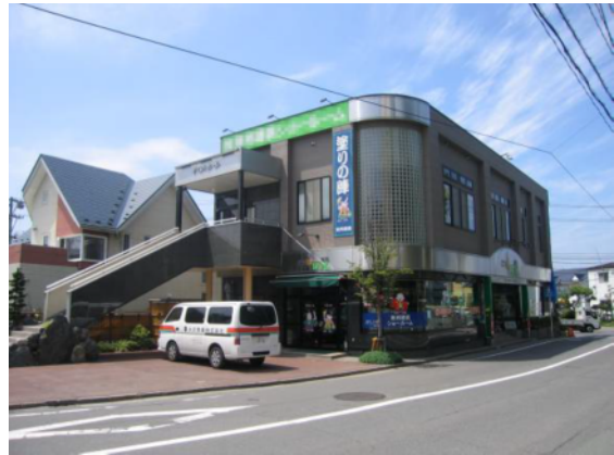
図-4.50 脱落箇所と逆側の面
