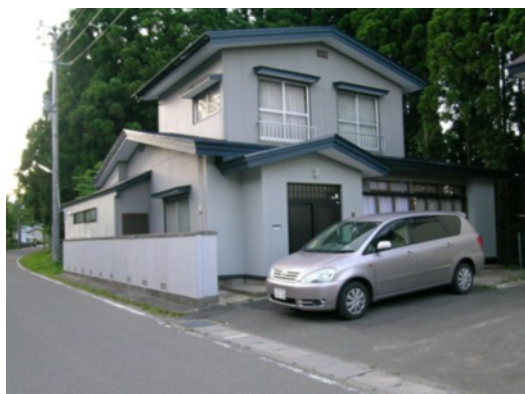
(c) 付近の住宅（無被害）
