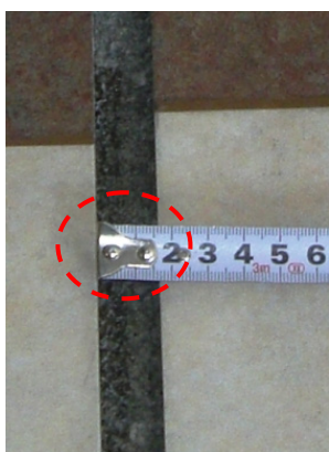
(b) 廊下内装のずれ （東西約1.5cm）
