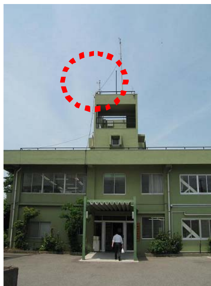
千葉港基地局の受信アンテナ
