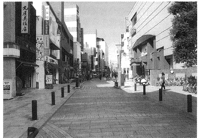
写真-3 生活道路整備後の状況
