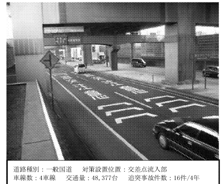
写真-1 減速路面表示の評価事例箇所
