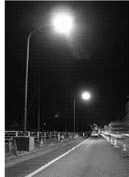
図-2 仮設照明の設置状況
