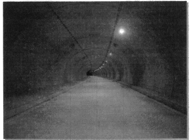
写真-3 トンネル照明の整備例
