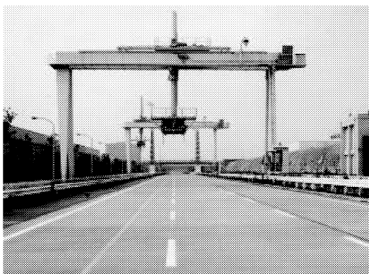
標識屋外実験施設
