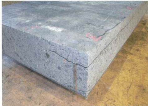
写真 4.6-1 床版断面のひび割れ
