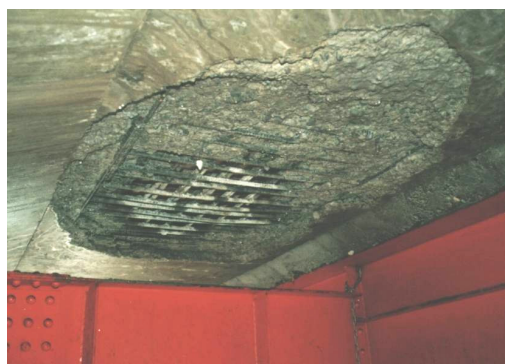
写真 2.3-2 実橋床版の劣化状況の例
