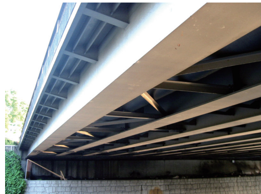
写真 4. 3-124 鋼床版裏面の状況
