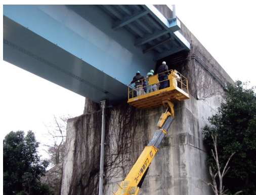
写真 4. 3-138 桁内調査の実施状況
