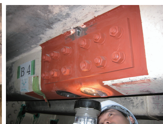
写真 4. 3-59 突き合わせ部の補強
