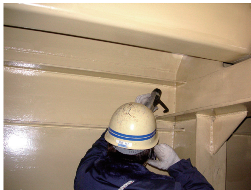
写真 4.3-114 桁内調査状況
