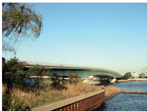
写真 4.3-34 M7 橋の全景
