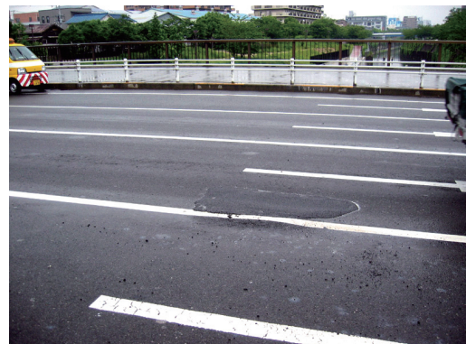
写真 4. 3-126 舗装の補修状況
