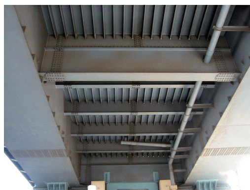
写真 4.3-31 鋼床版の状況
