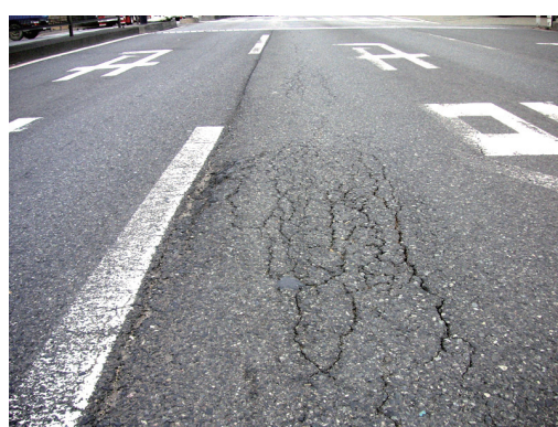
写真 4.3-130 舗装の損傷
