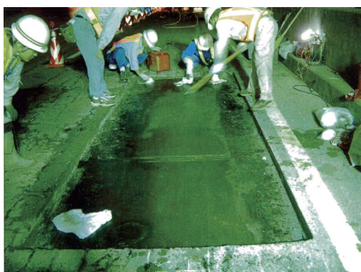
写真 4.3-27 舗装切削調査状況
