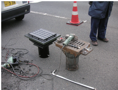
写真 4. 3-133 排水柵の取替え状況
