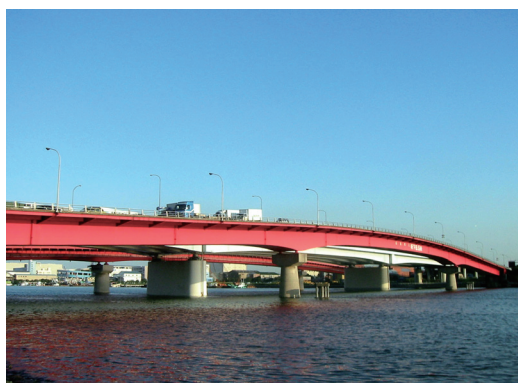
写真 4.3-36 M8 橋の全景
