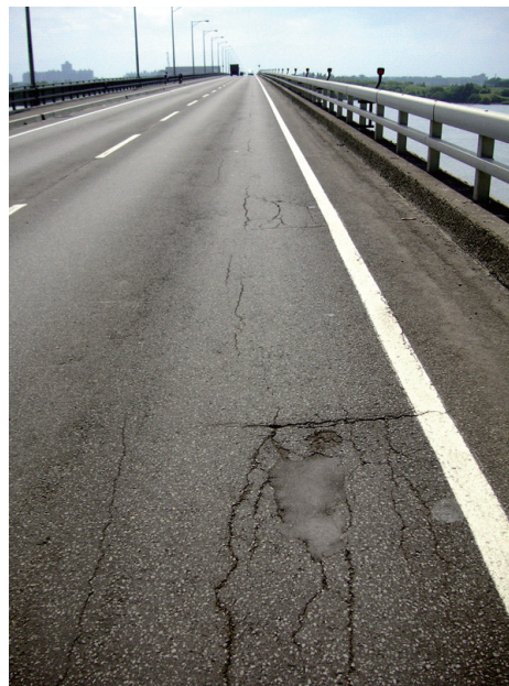
写真 4.3-12 舗装の損傷
