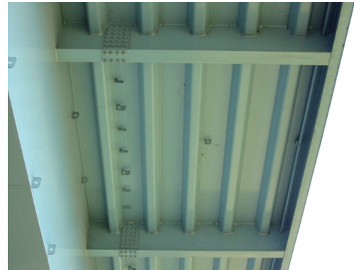
写真 4.3-75 ブラケット部の鋼床版
