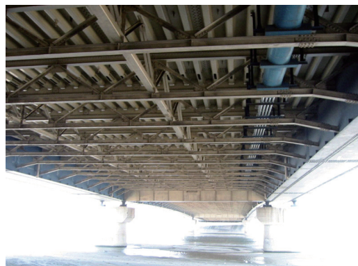
写真 4.3-128 中床版の鋼床版状況
