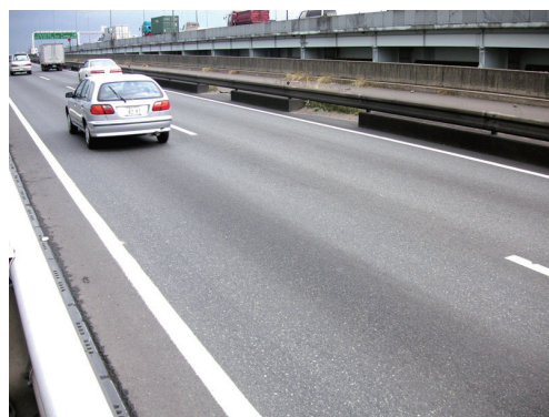
写真 4.2-2 路肩のガードレール設置例
