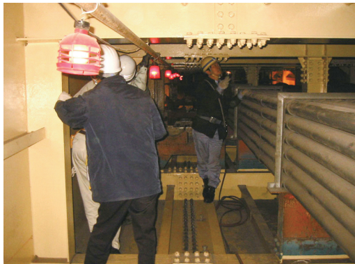
写真 4.3-109 桁内調査状況
