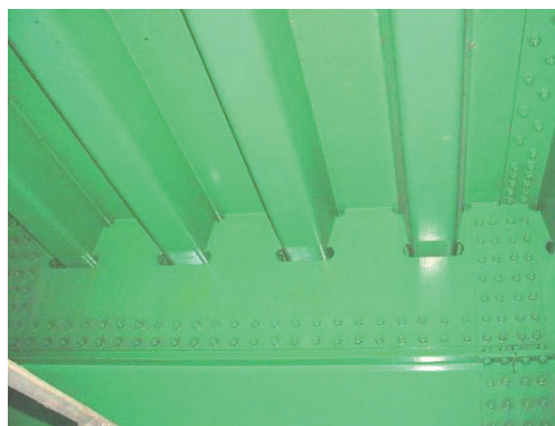
写真 4.3-83 鋼床版の状況
