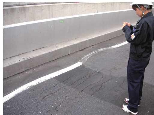
写真 4.3-47 路面調査状況
