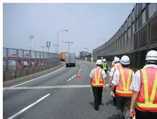
写真 4.3-142 路面調査状況
