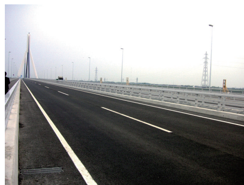
写真 4.3-20 交通実態と路面の状況
