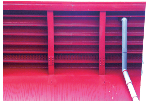
写真 4. 3-87 ブラケット部鋼床版
