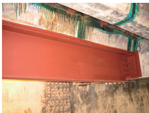
写真 4. 3-58 H型鋼による補強
