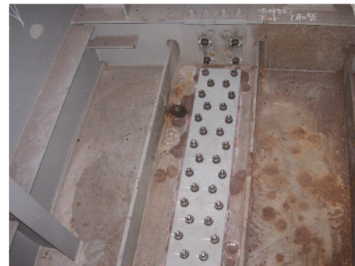
写真 4. 3-134 腐食部の補修状況
