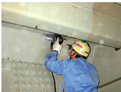
写真 4. 3-140 磁粉探傷試験状況
