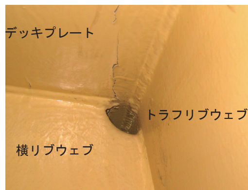
写真 3.5-11 スカラップ周辺の塗膜割れ
