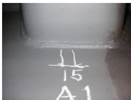
写真 3.5-16 トラフリブ・端横リブ（または端横げた）溶接部の塗膜割れ
