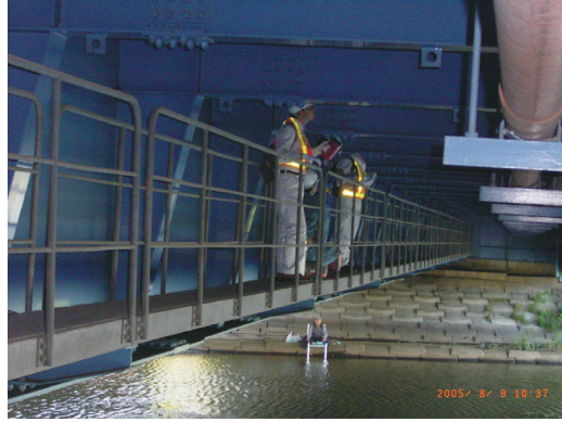
写真 3.5-2 検査路からの調査状況
