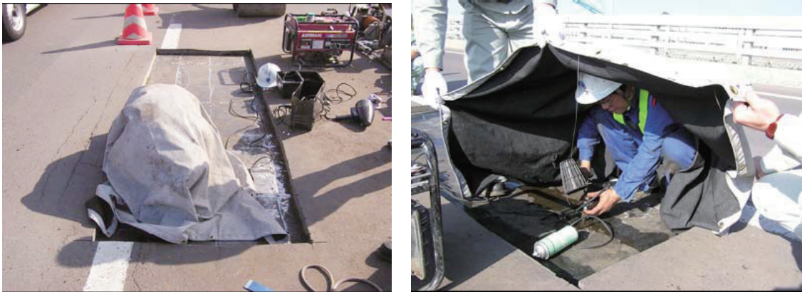
写真 3.6-3 磁粉探傷試験実施状況(日中の場合)
