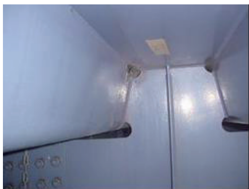
写真 3.5-10 交差部の発錆
