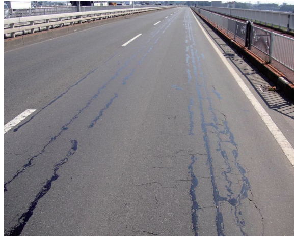
写真 3.3-5 舗装のひび割れ
