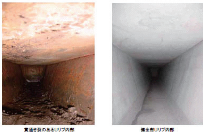
写真 3.9-2 縦リブ内部の堆積物
