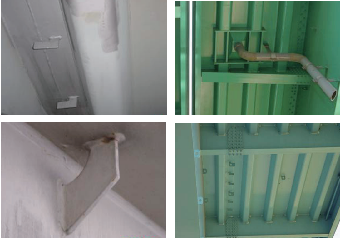
写真 3.5-19 デッキプレート下面に溶接施工された付属物および架設治具の例
