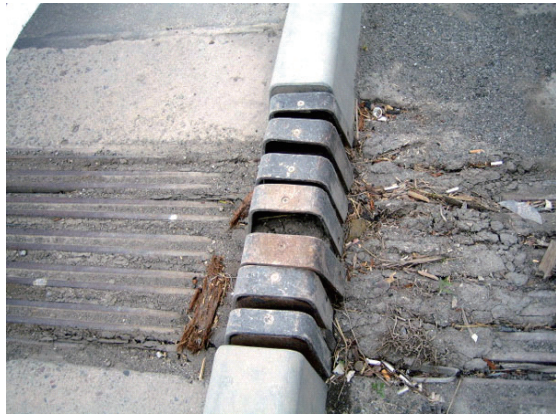
写真 3.3-16 ビーム型伸縮装置の破損事例
