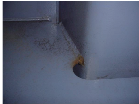
写真 3.5-13 トラフリブ・横リブ交差部の発錆
