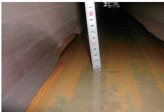
写真 3.8-2 トラフリブ内に水あり 写真 3.8-3 トラフリブ内に堆積物（粘土）あり
