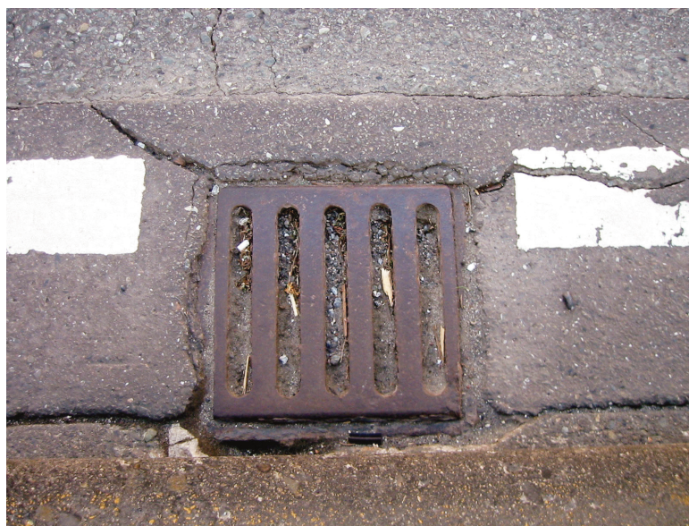
写真 3.3-18 土砂の流入により閉塞した排水柵
