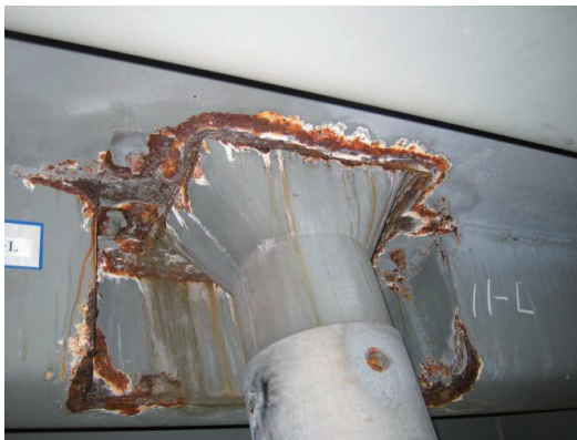
(c) 箱げた内に引き込まれた排水管の不全
