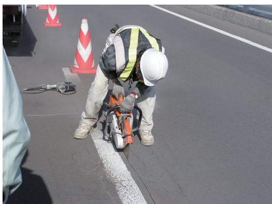
写真 3.5-24 アスファルト切断状況
