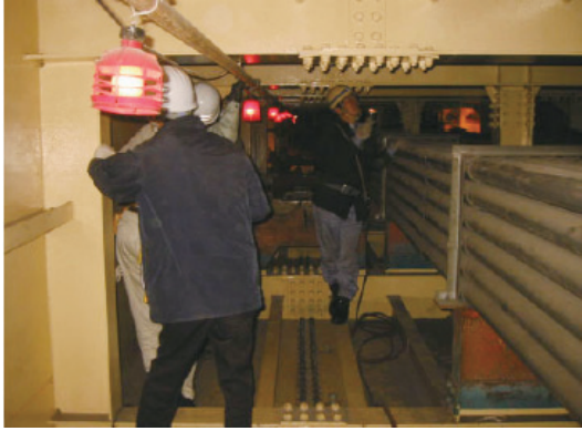
写真 3.5-1 箱げた内部からの調査状況
