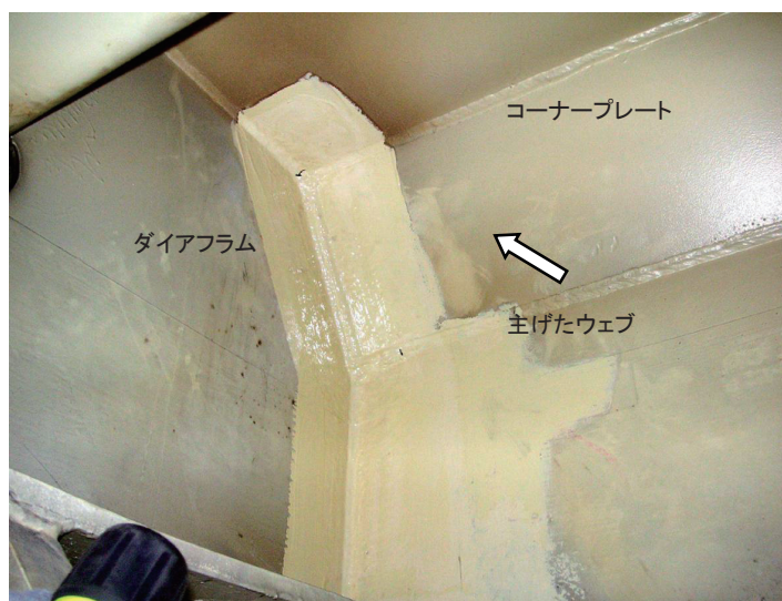
写真 3.3-14 コーナープレート部の疲労損傷（補修跡）
