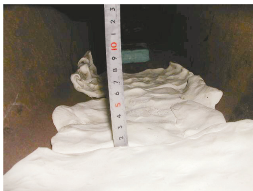
写真 3.8-2 トラフリブ内に水あり 写真 3.8-3 トラフリブ内に堆積物（粘土）あり
