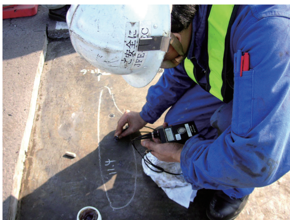
写真 3.10-1 超音波板厚計測状況
