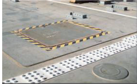
写真 3.5-27 マンホールダブリングの突出
