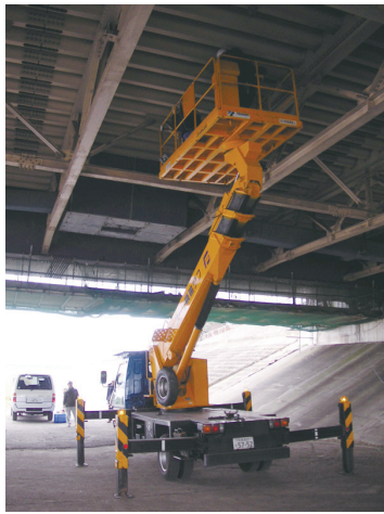
写真 3.5-3 高所作業車からの調査状況
