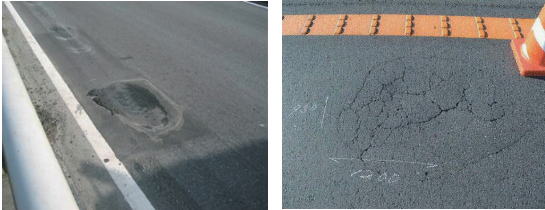
写真 3.3-3 デッキプレート貫通き裂上に確認された舗装のひび割れの事例
