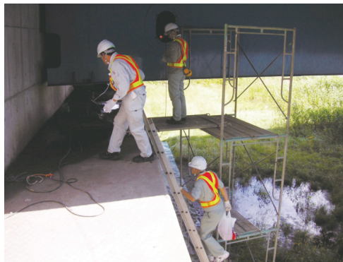
写真 3.5-5 仮設足場からの調査状況
