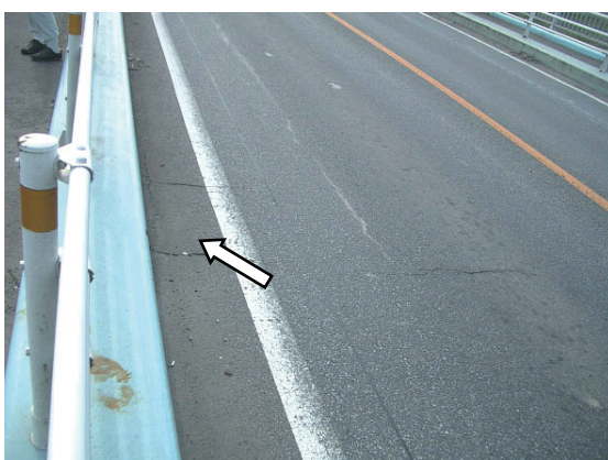
写真 3.3-10 横断方向の舗装ひび割れ
