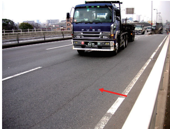
b) 舗装のひび割れの例
