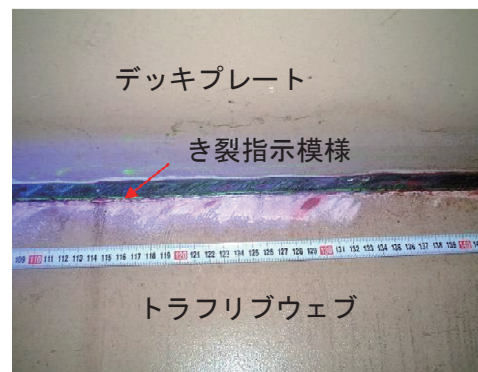
写真 3.5-9 塗膜の部分的な除去 （除去後に磁粉探傷試験実施）
