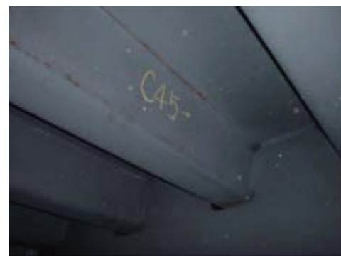
写真 3.5-7 トラフリブ・デッキプレート 溶接部の発錆
