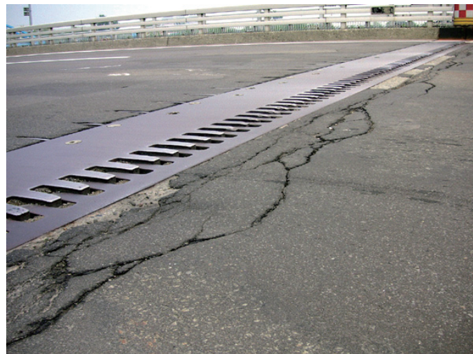
写真 3.3-17 段差の生じた伸縮装置
