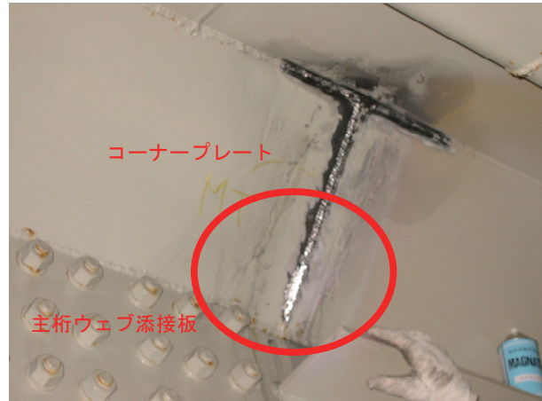
写真 3. 6-15 主桁ウェブコーナープレート継手部 (目視点検後の塗膜除去状況)
