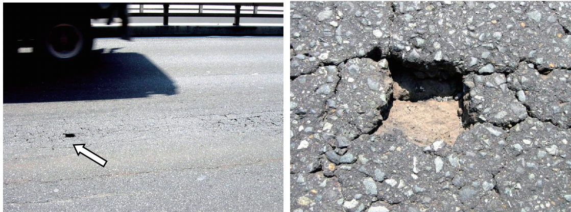
写真 3.3-11 舗装の剥離によるポットホール（右は矢印部分の拡大）
