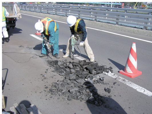
写真 3.5-25 アスファルト破碎状況
