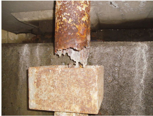
写真 3.3-19 凍結防止剤により腐食した排水管
