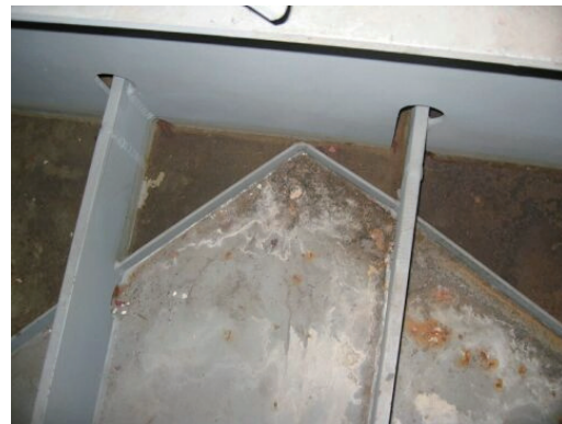
(f) 水抜き孔の不設置
