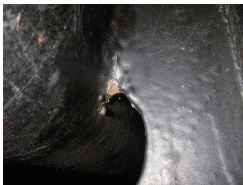
写真 3.5-12 トラフリブ・横リブ交差部の塗膜割れ
