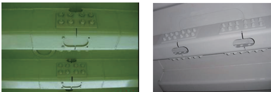
写真 3.5-15 トラフリブ現場高力ボルト継手部
