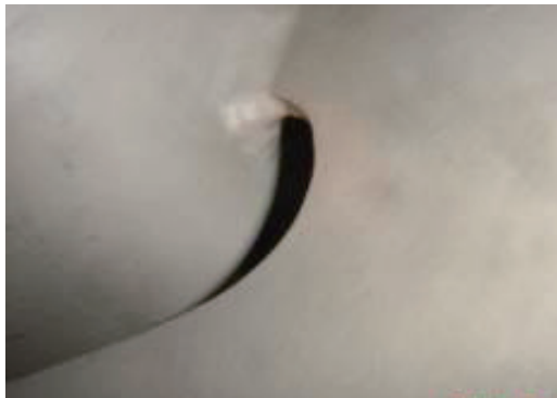
写真 3.5-13 トラフリブ・横リブ交差部の発錆
