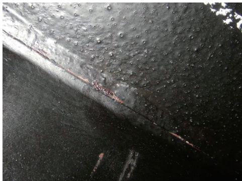
写真 3.5-6 トラフリブ・デッキプレート 溶接部の塗膜割れ
