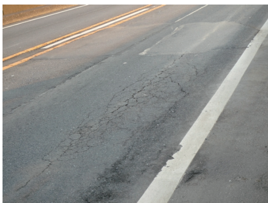
写真 3.3-6 ビード貫通き裂と舗装のひび割れ
