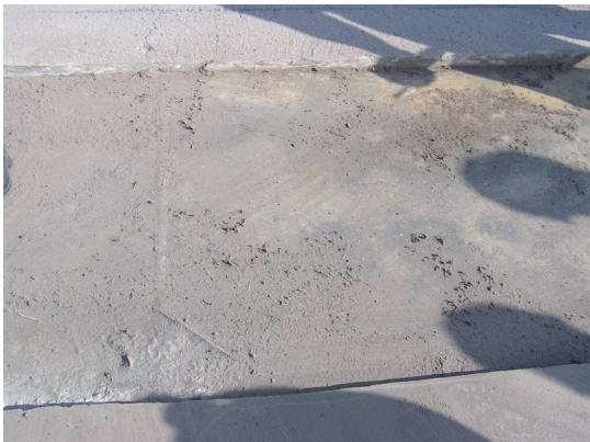
写真 3.5-28 アスファルト撤去
