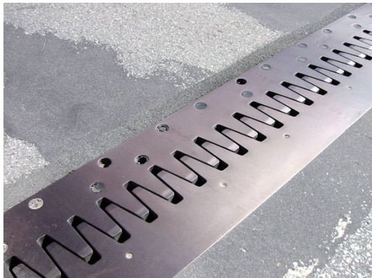
写真 3.3-15 フェイスプレート取付けボルトの脱落
