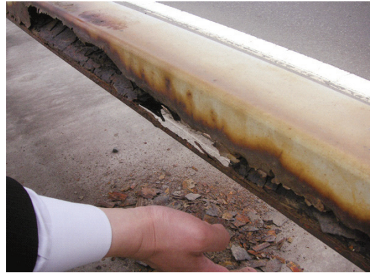
写真 3.3-20 高欄の腐食
