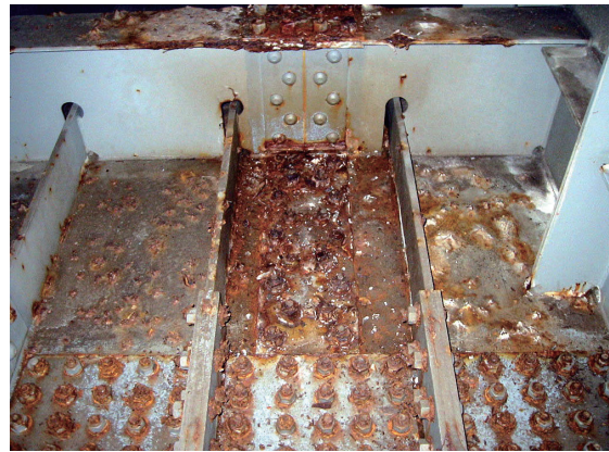
(b) 箱げた内の腐食
