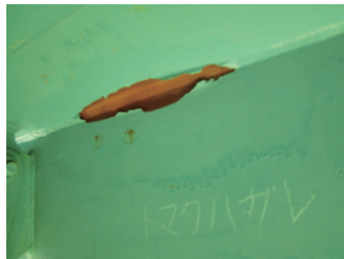
写真 3.6-9 左図位置の塗膜はがれ状況
