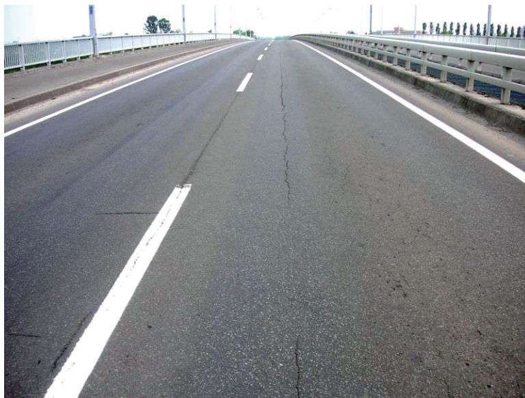
写真 3.3-13 主げたウェブ上のひび割れ
