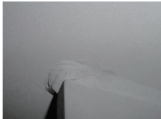
写真 3.5-17 主げた垂直補剛材上端部・デッキプレート下面溶接部の塗膜割れ
