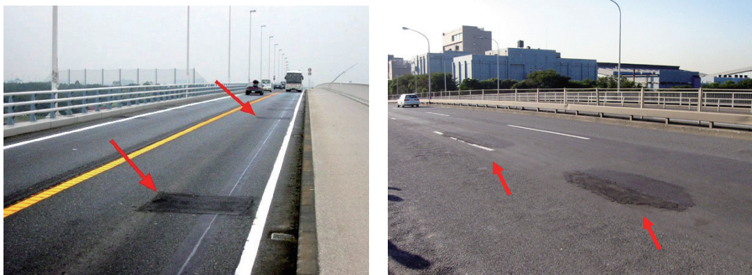
a) 部分補修の例 1 (M10 橋)
