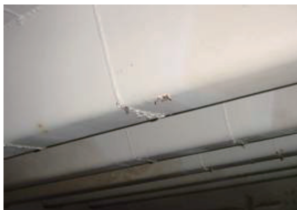
写真 3.5-14 トラフリブ現場溶接継手部の発錆の例
