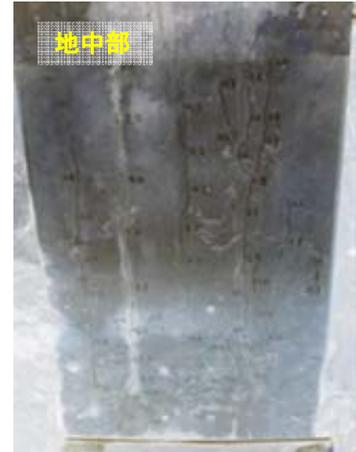
写真-4 柱部のひび割れ状況
