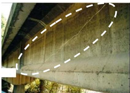
写真-1 PC 鋼材に沿ったひび割れ
