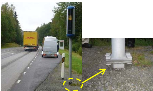
図-3 スピードカメラ (左) と基礎部分 (右)
