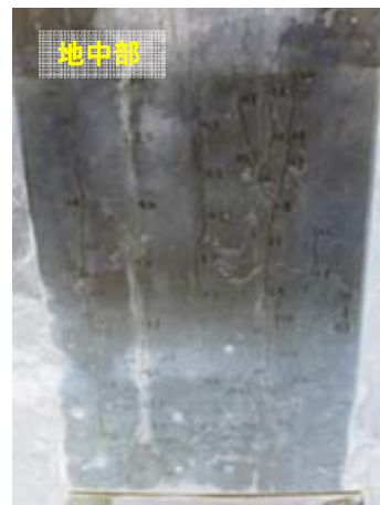
写真-4 柱部のひび割れ状況
