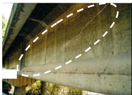
写真-1 PC 鋼材に沿ったひび割れ
