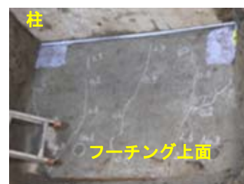
写真-5 フーチング上面のひび割れ状況
