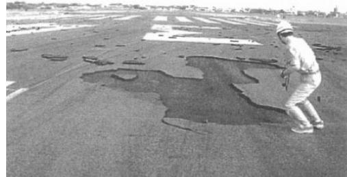
写真-1 2000年7月の名古屋空港滑走路の破損
