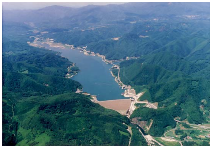
写真6.3.1 セケ宿ダム(「ダム便覧」 [30] より引用)
