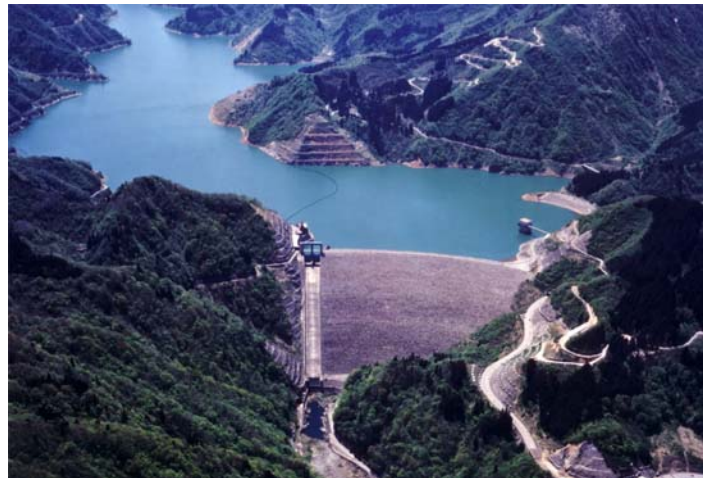
写真6.3.2 手取川ダム(「ダム便覧」 [34] より引用)
