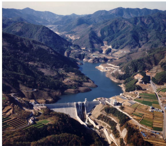
写真6.2.2 野村ダム(「ダム便覧」 [17] より引用)
