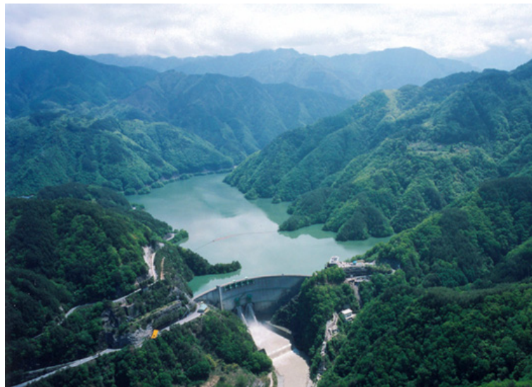
写真6.4.2 小渋ダム(「ダム便覧」 [40] より引用)
