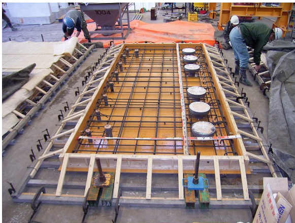
PC版配筋状況
