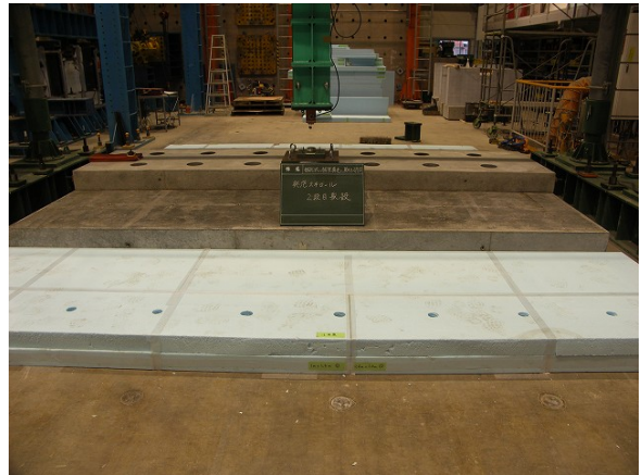
2層目発泡スチロール敷設状況
