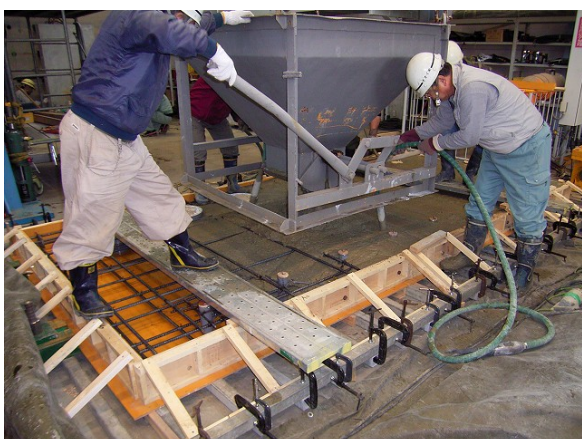
PC版のコンクリート打設状況
