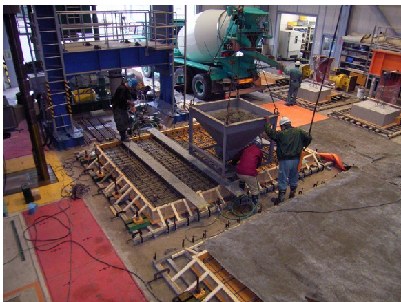
枕版のコンクリート打設状況
