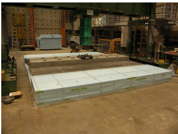
3, 4層目発泡スチロール敷設状況
