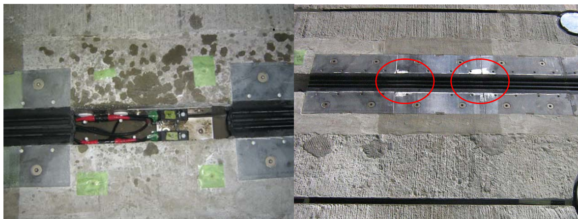
(a) 地下水有，ボルト締結無の50回走行後の水の噴出 (b) 目地構造のプレートとゴムの摩耗 写真-25 条件4の50回走行載荷試験後のPC版舗装の路面状況
