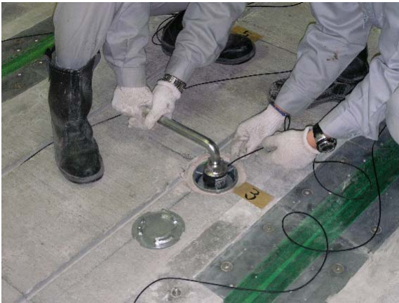
写真-23 締結ボルトの緊張作業状況
