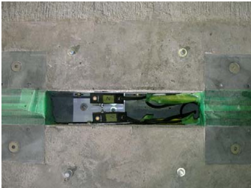
写真-24 レーザー変位計の設置状況
