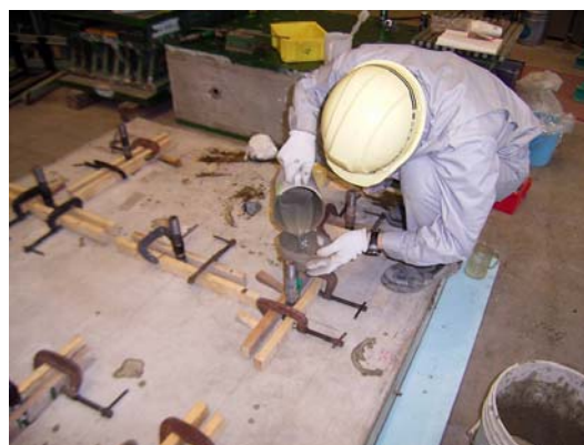
写真-16 エポキシ樹脂注入状況
