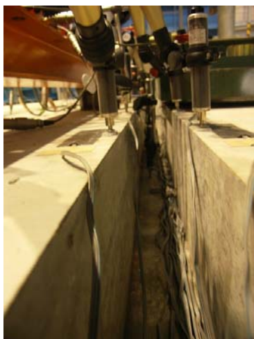
(PC版・枕版間に生じた隙間)
