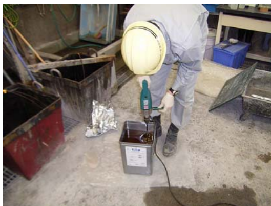
写真-13 エポキシ樹脂練混ぜ状況
