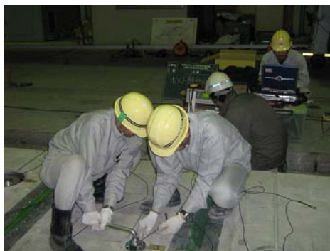
写真-12 締結力の導入状況
