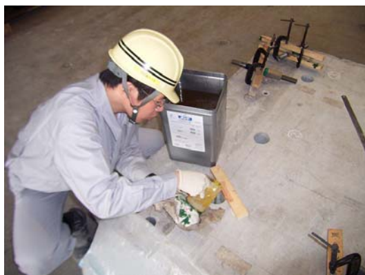
写真-15 エポキシ樹脂注入状況
