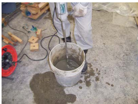
写真-14 モルタル練混ぜ状況
