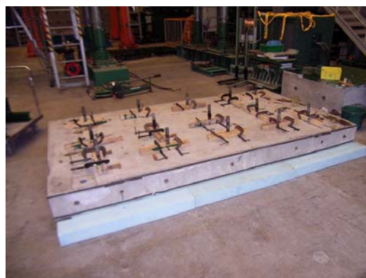
写真-17 アンカー固定状況
