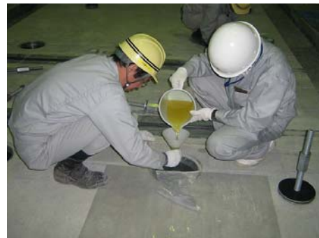
図-63 ボルト定着用エポキシ樹脂注入
