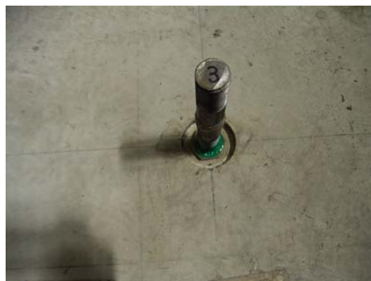
写真-18 アンカー設置完了
