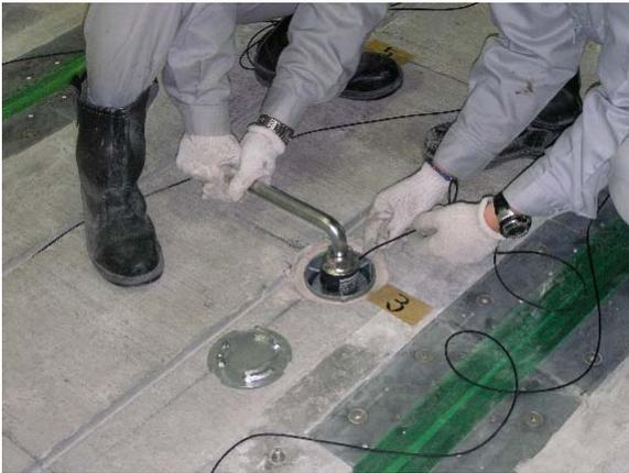
写真-23 締結ボルトの緊張作業状況
