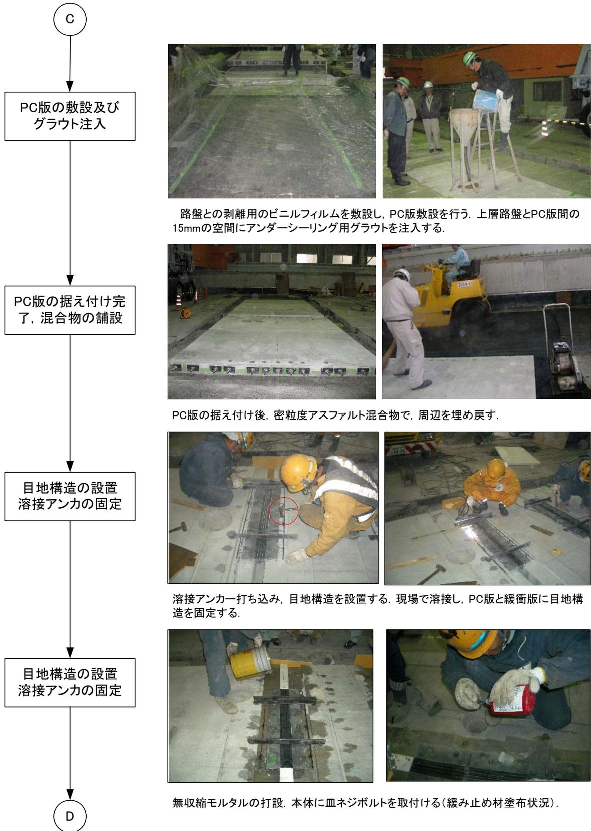
図-84 PC版設置及び目地構造の設置 作業フロー
