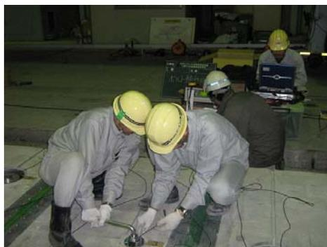
写真-12 締結力の導入状況
