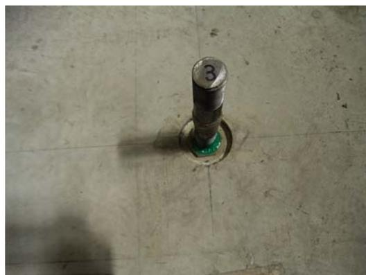
写真-18 アンカー設置完了
