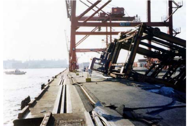
(b) レールの変形等の状況
