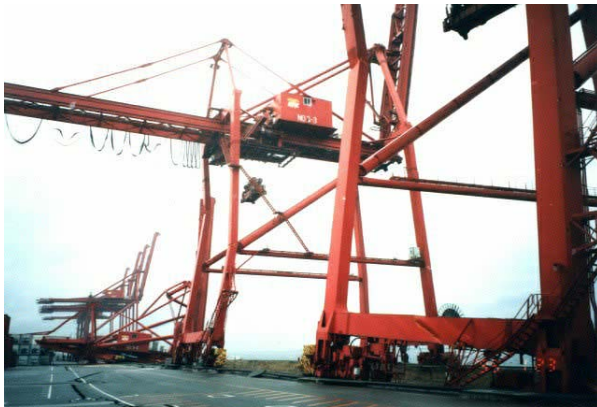
(a) 脚の折れ曲がり等の状況
