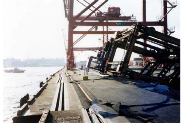
(b) レールの変形等の状況
