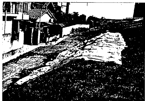
図-5.2 被災状況（江戸川 No. 6）
