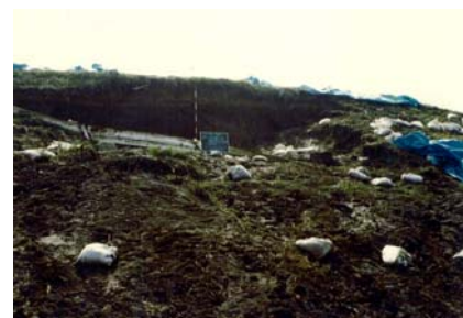
図-3.14 被災状況（荒川 No. 12）
