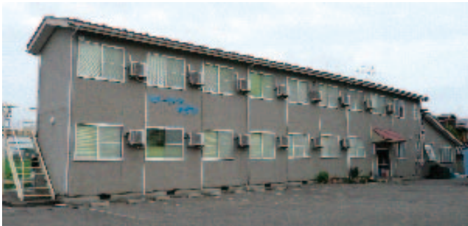
写真-9.4.21 部分的に大破した木造共同住宅
