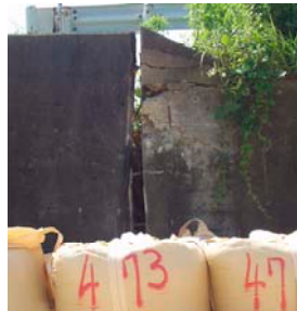
接合部右側擁壁のはらみ
