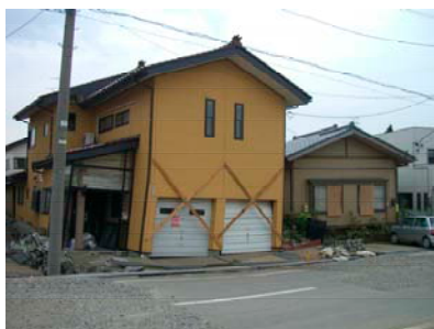
写真-9.7.1 柏崎市松波地区の液状化被害
