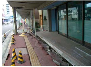
写真-9.7.21 杭基礎建物の被害
