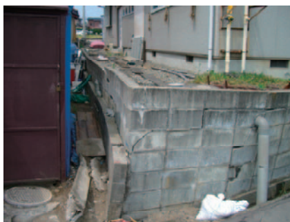
左：地盤変動による被害が甚大であった地点の状況 中：上記地点において建物の不同沈下を増大させたと考えられる擁壁の変形 右：川に沿った道路の変形に伴う電信柱の傾斜
