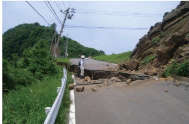
写真-3.14 市道に生じた段差(7月19日撮影)
