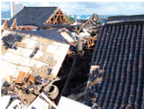
写真-9.5.6 煙突と木造工場 (写真中央に、煙突の低層部(奥)、中層部、先端部(手前)が3本見える)
