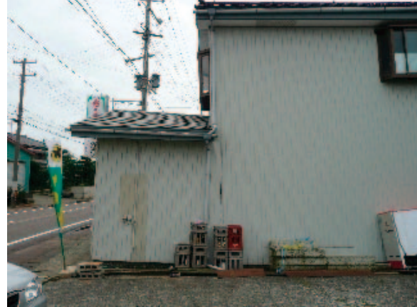
写真-9.4.16 写真-9.4.17 の敷地の噴砂痕 写真-9.4.17 不同沈下した店舗併用住宅 (平屋と2階建て部分の境界付近が不同沈下)
