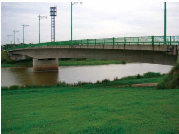
写真-7.27 平成大橋
