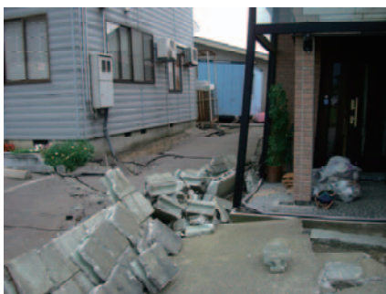
左：地盤変動による被害が甚大であった地点の状況 中：上記地点において建物の不同沈下を増大させたと考えられる擁壁の変形 右：川に沿った道路の変形に伴う電信柱の傾斜
