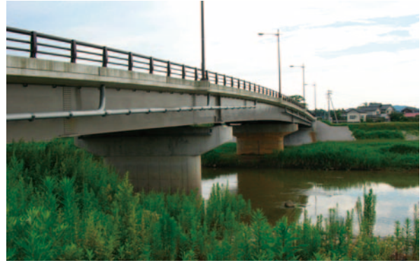
写真-7.22 なごみ橋
