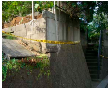
写真-9.7.17 山本団地における擁壁の被害例
