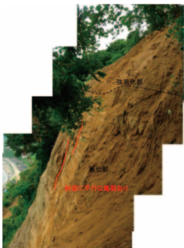
写真-8.3.18 斜面崩壊頭部付近（柏崎地域振興局（2007）による）
