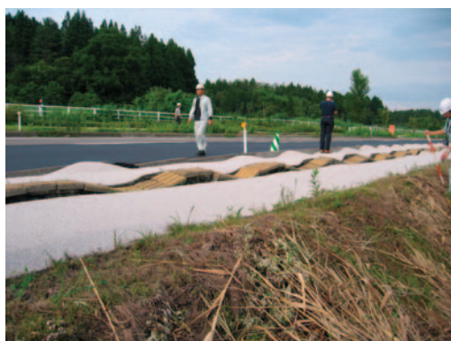
(b) 歩道の変状状況
