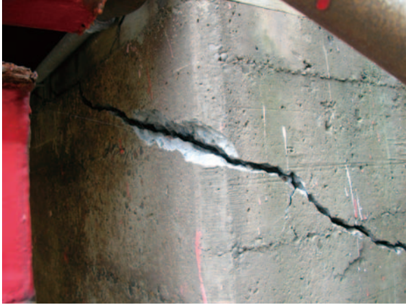
(a) パラペットのひびわれ
