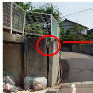
コンクリート擁壁のはらみ
