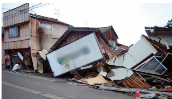
写真-9.4.3 倒壊した店舗併用住宅
