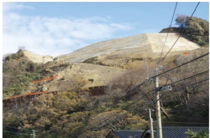
写真-3.15 対策状況 (新潟県提供：11月20日撮影)
