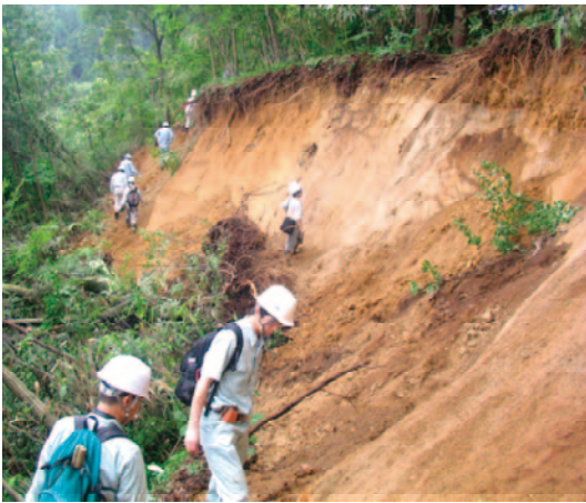
写真-8.3.13 頭部滑落崖の規模は、幅約60m、奥行き約60mで、斜面傾斜は約20°である。
