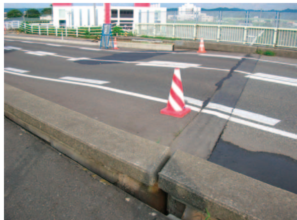
写真-7.34 跨線橋橋台背面土の沈下
