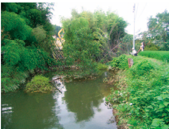
写真-8.3.6 黒川の湛水状況
