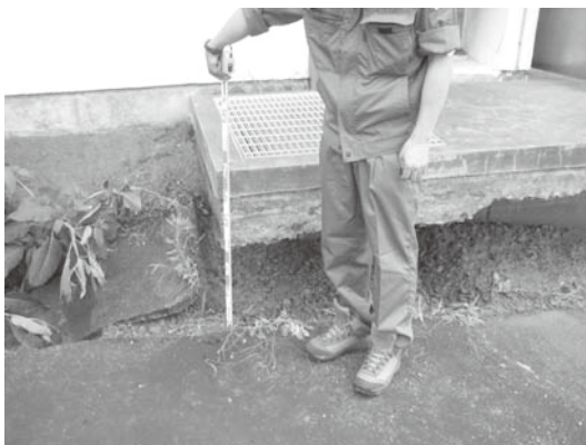
写真-4.8 八坂ポンプ場地盤沈下
