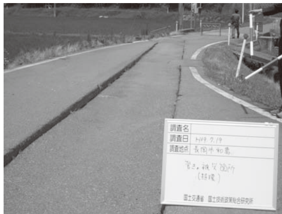
写真-4.3 埋戻し部沈下 (長岡市和島)
