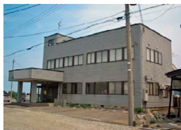
写真-9.7.10 鉄骨造 2 階の建物の不同沈下 （基礎形式：直接基礎、数十 cm の不同沈下）
