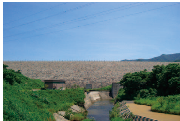
写真-6.1 柿崎川ダム（下流から）
