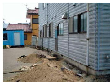
写真-9.7.10 鉄骨造 2 階の建物の不同沈下 （基礎形式：直接基礎、数十 cm の不同沈下）
