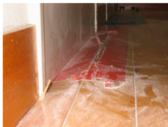
写真-9.6.8 床仕上材のせり上がり
