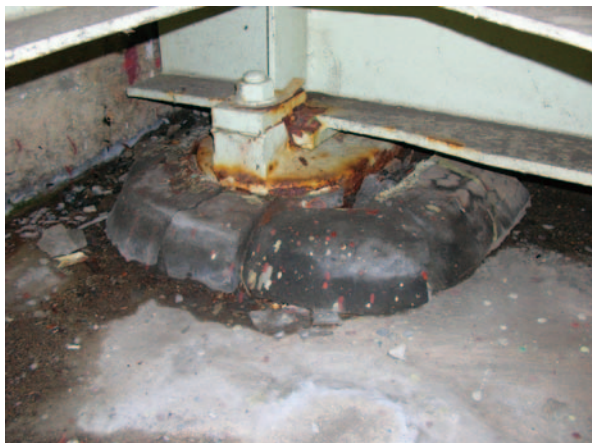
写真-7.33 沓座モルタルの破損
