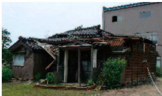
写真-9.4.9 2階が崩壊した例
