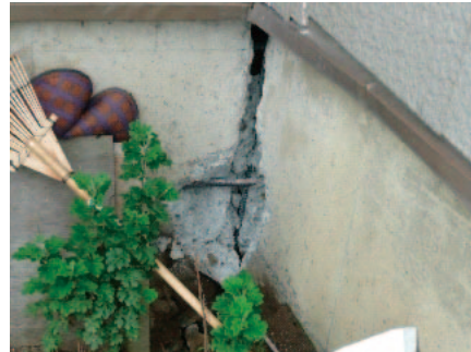
写真-9.4.23 地盤変状で破壊した基礎
