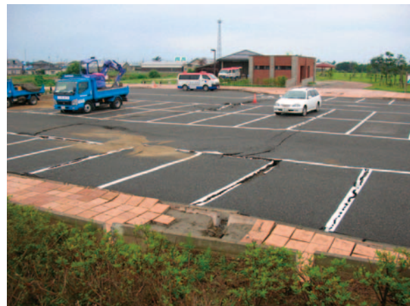
写真-7.28 隣接する公園駐車場の液状化による路面のうねり
