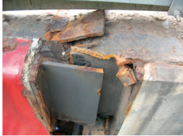
(b) 伸縮装置の変形
