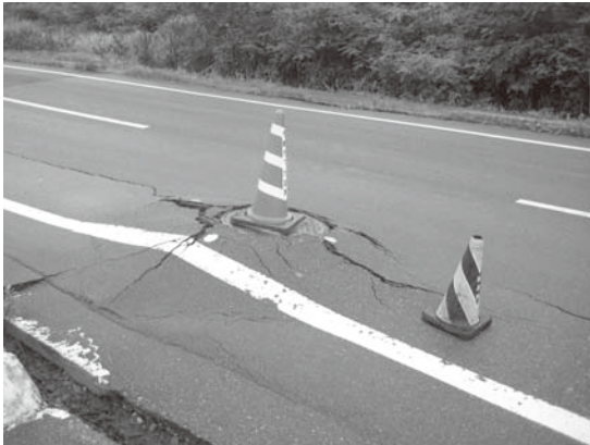
写真-4.1 マンホール隆起 (柏崎市栄町)
