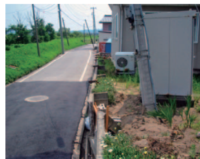
左：地盤変動による被害が甚大であった地点の状況 中：上記地点において建物の不同沈下を増大させたと考えられる擁壁の変形 右：川に沿った道路の変形に伴う電信柱の傾斜
