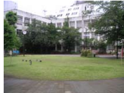
南桜公園 旧小学校の建物は港区住宅公社として利用されている。公園と建物との関係は、当初の面影が残されている。
