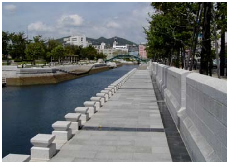
「水際のプロムナード」エリアの園路 防護施設を最小限にとどめることにより、良好な水際の眺望を確保している。
