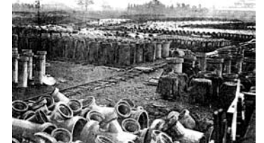
鉄筋コンクリート管製作工事
