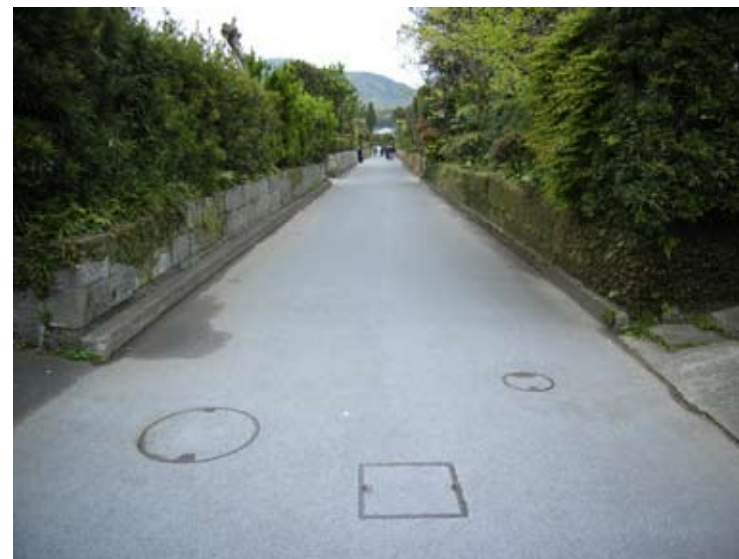
グレー系脱色アスファルト舗装 桝蓋等は道路路上に出現するものを極力少なくするとともに舗装との一体感を持たせている。
