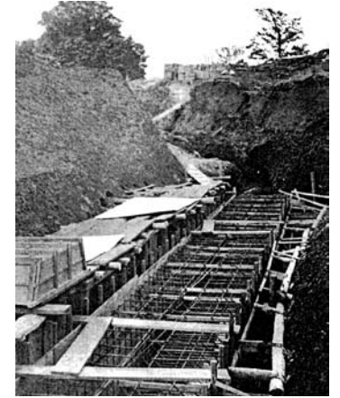
ボックスカルバート築造工事
