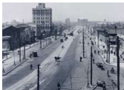
拡張工事後の様子
