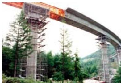
押し出し工法による施工中の様子
