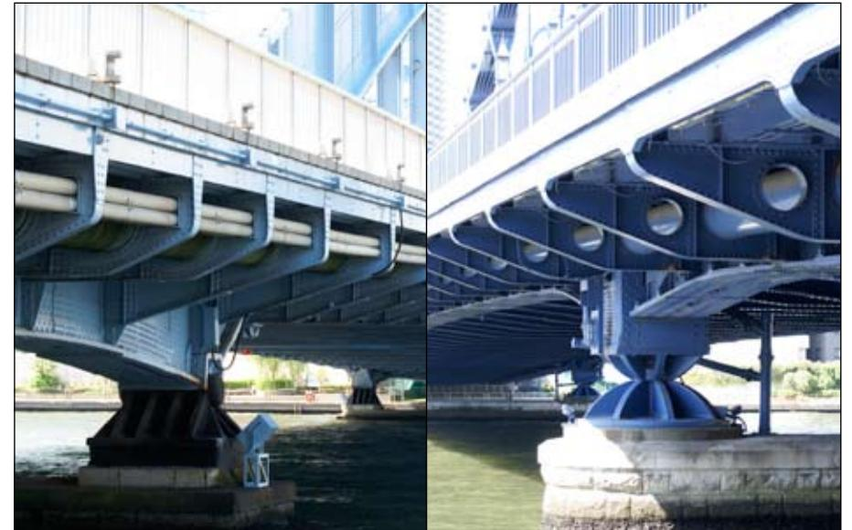
船運が盛んだった昭和初期に造られた隅田川橋梁群は、ブラケットなどの桁側面の表情を始めとして、桁裏や支承、橋脚などのディテールが、見られることを意識したデザインとなっている。平成に入って整備されたライトアップ用の配管や灯具が、昼の景観を妨げているのが残念である（左：永代橋、右：清洲橋）
