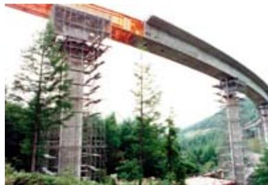
押出し工法による施工中の様子
