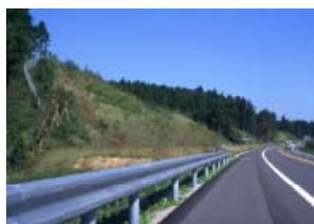
前付け植栽による伐開断面の保護
