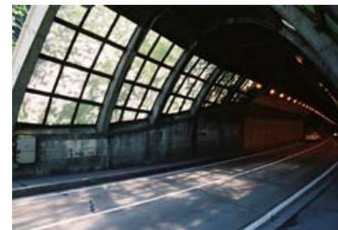
入口から内部へ徐々に採光面積が少なくなる坑口により運転者の明暗順応を図っている。
