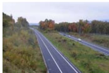
盛土築堤 防護柵を排除している。
