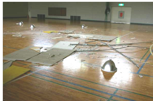
写真-7.18 脱落した様々な部材
