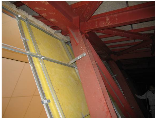
写真-7.23 プロセニウムアーチ上部の天井裏
