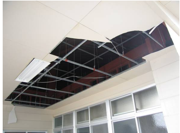
写真-7.32 脱落した軒天井
