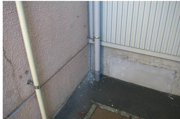
写真-7.30 増築部分の接続箇所
