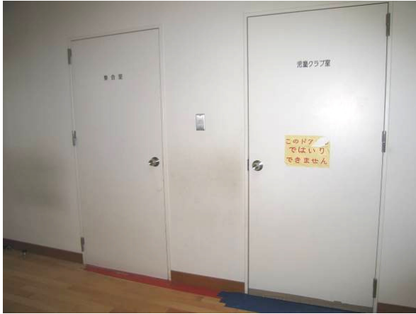
写真-7.24 開扉に支障を来した防火扉
