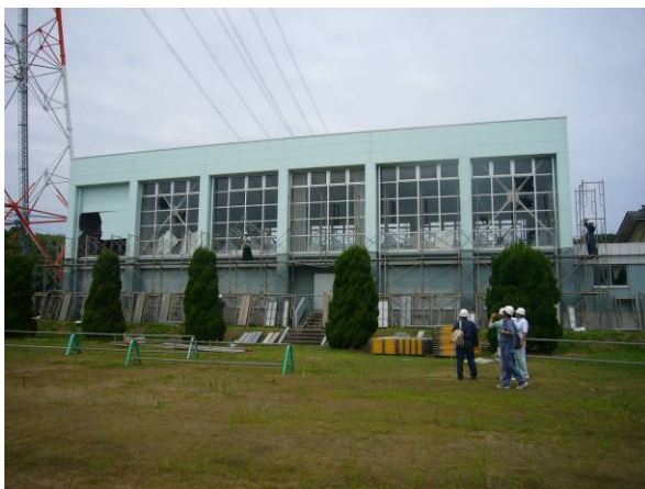
写真-7.8 建物D外観
