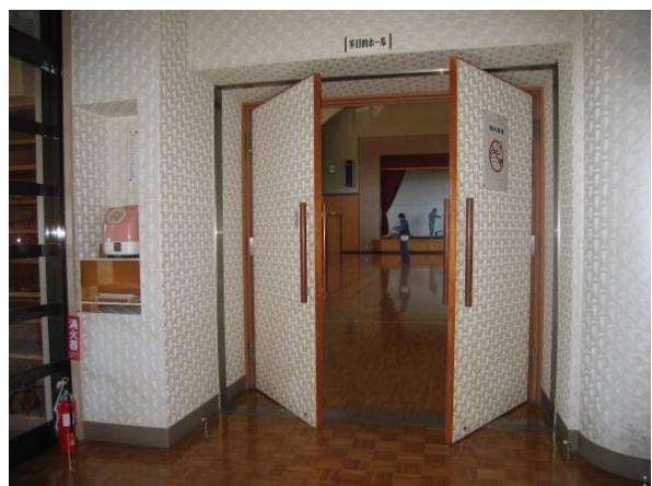
写真-7.2 不具合が生じた扉
