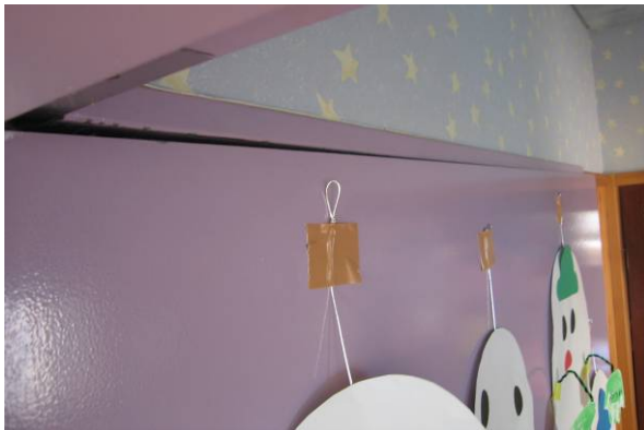
写真-7.29 納まらなくなった防火扉
