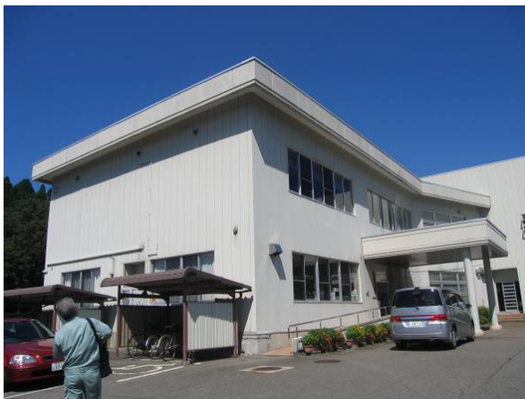
写真-7.26 建物 J 外観
