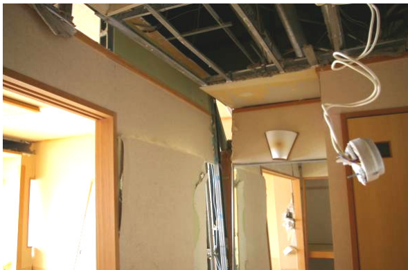
写真-7.33 天井や間仕切り壁が破損した客室
