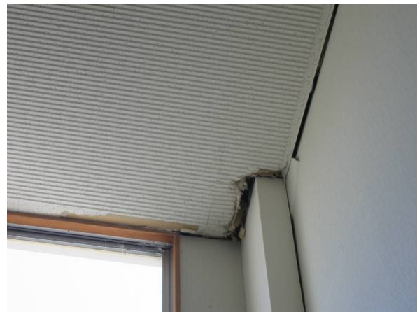
写真-7.27 吹き抜け上部の天井被害
