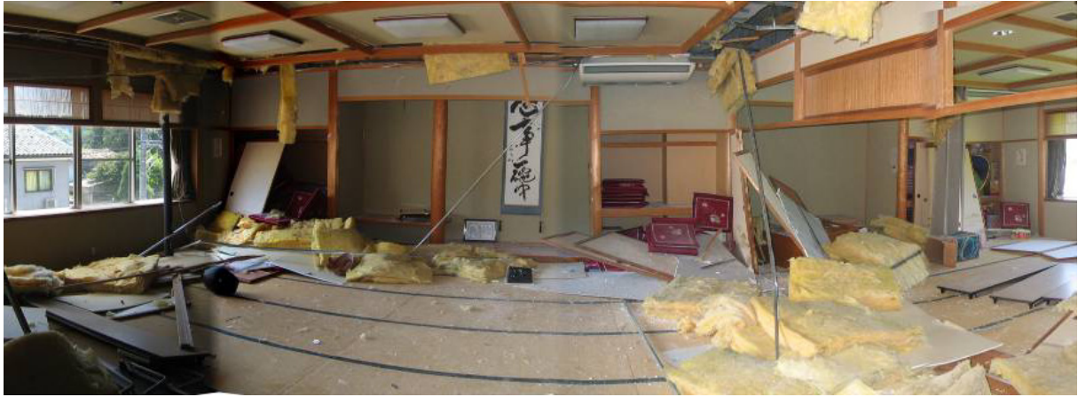
写真-7.28 2階和室内部被害状況（パノラマ合成）
