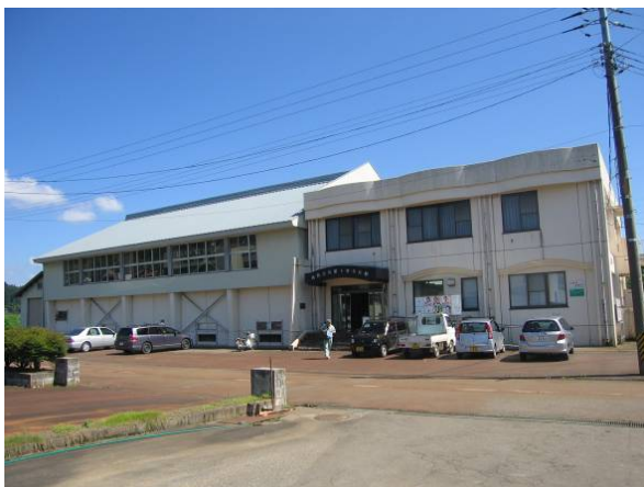
写真-7.1 建物A 外観
