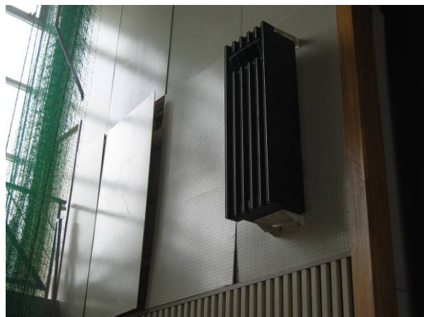
写真-7.12 下地から浮いた有孔合板
