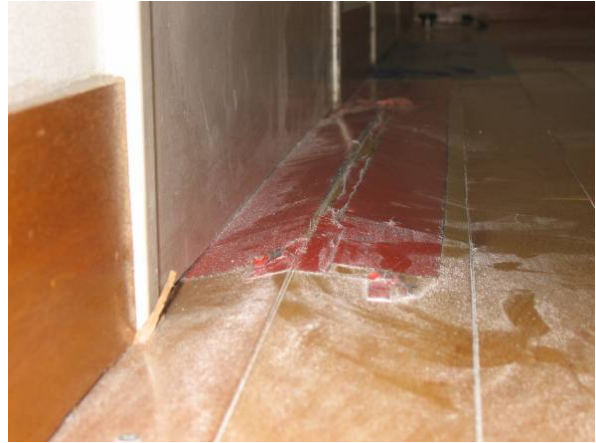
写真-7.25 床仕上材のせり上がり
