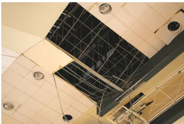
写真-7.17 脱落した天井箇所
