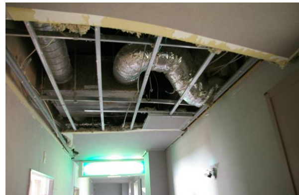
写真-7.34 廊下の天井の脱落
