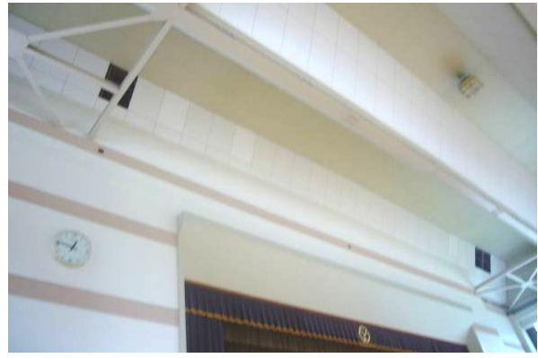
写真-7.22 グラスウォールボードの脱落
