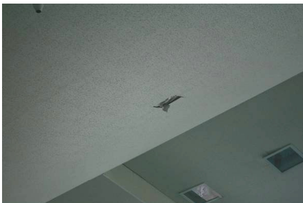
写真-7.13 50m プールの天井にあいた穴
