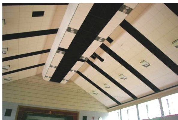
写真-7.20 同建物の体育館の天井
