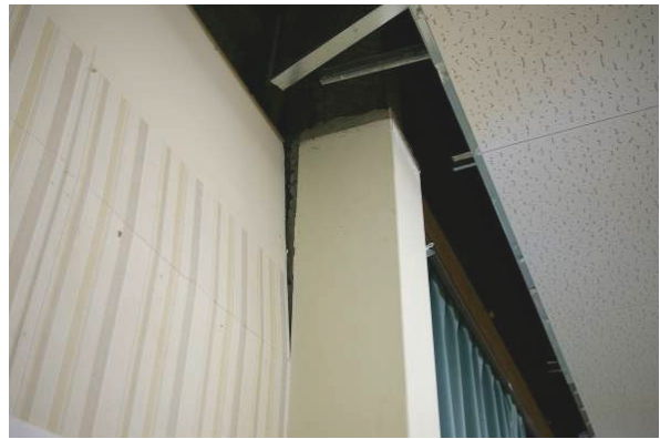
写真-7.7 会議室の天井被害
