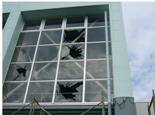
写真-7.9 ガラスの被害
