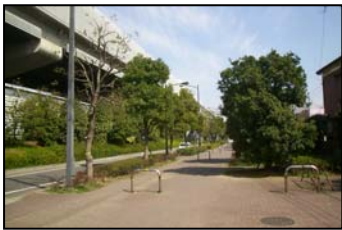
写真-2 東京外かん道路 （環境施設帯）
