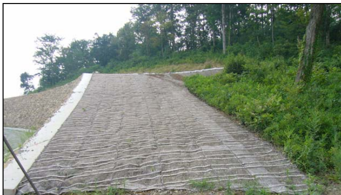
写真-5 国営備北丘陵公園の自然侵入促進工の施工直後
