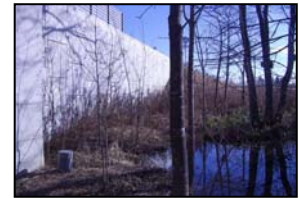
写真-2 擁壁工付近の湿地環境の状況
