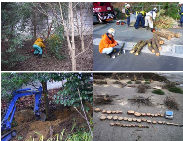
写真1 樹木の伐採及びサンプル採取状況
