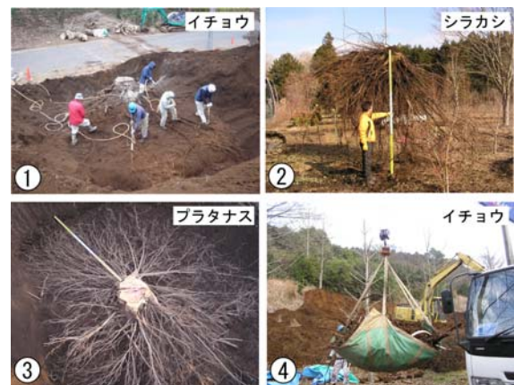
写真2 根の掘取り作業
