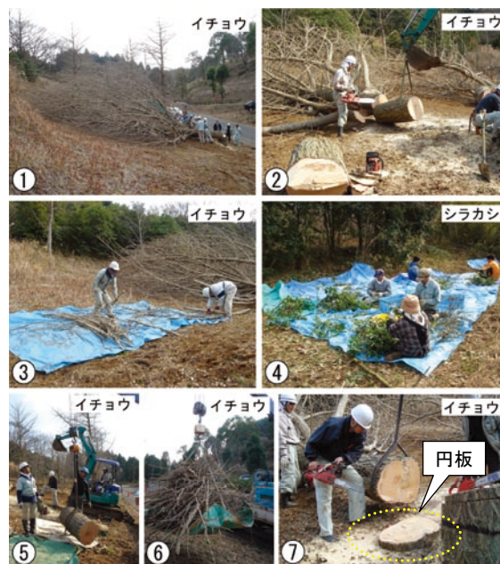
写真1 地上部の伐倒作業
