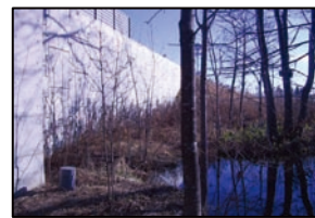
写真-2 擁壁工付近の湿地環境の状況 【R236帯広尾道路】
