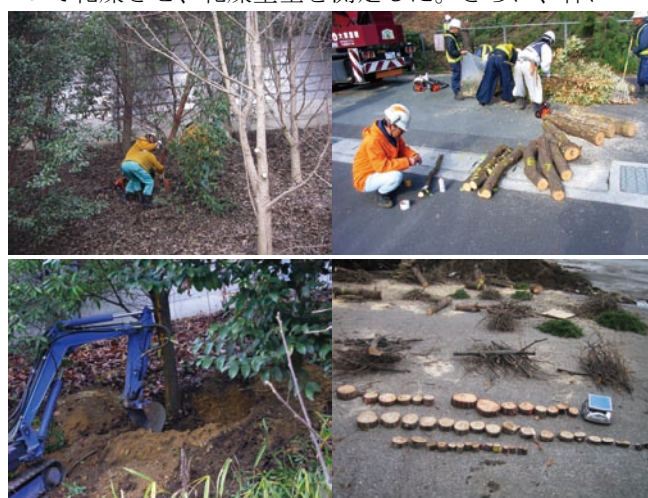
写真 1 樹木の伐採及びサンプル採取状況
