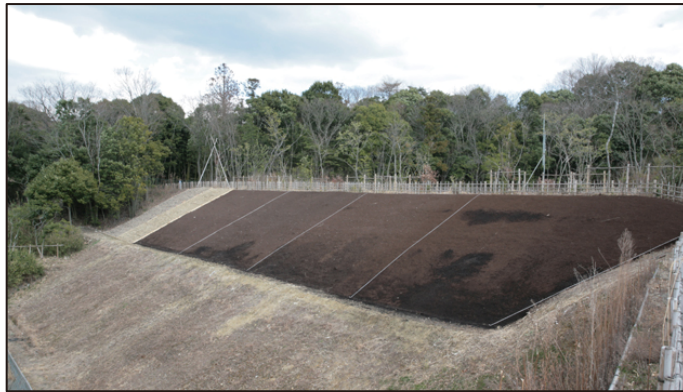
写真－1 国営明石海峡公園の表土利用工の施工直後のり面上段の左奥から水田、草地、森林の表土を用いた試験区。
