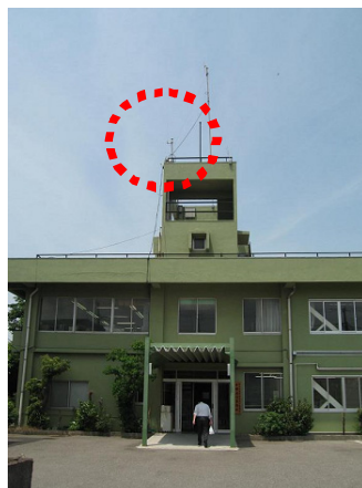
千葉港基地局の受信アンテナ
