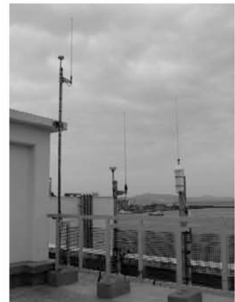
久里浜基地局の受信アンテナ
