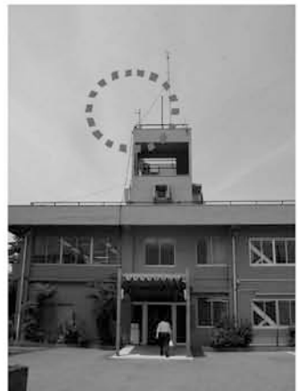
千葉港基地局の受信アンテナ
